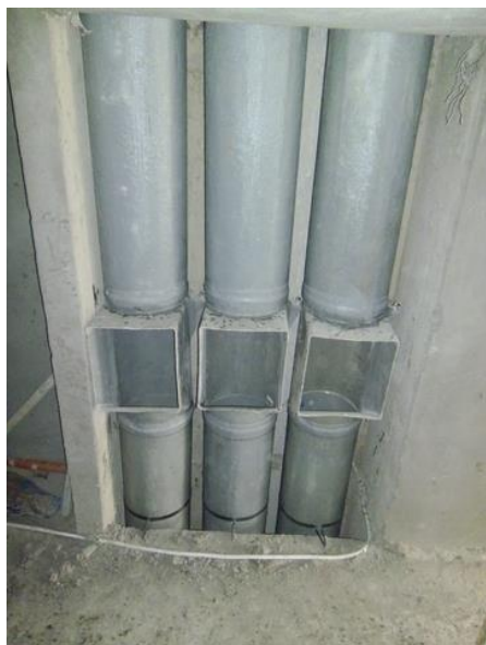
Figura 163.vista del detalle de los ductos de basura
