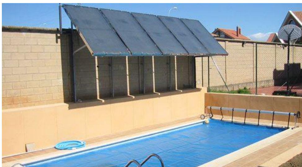
Figura 150. Calentadores solares
