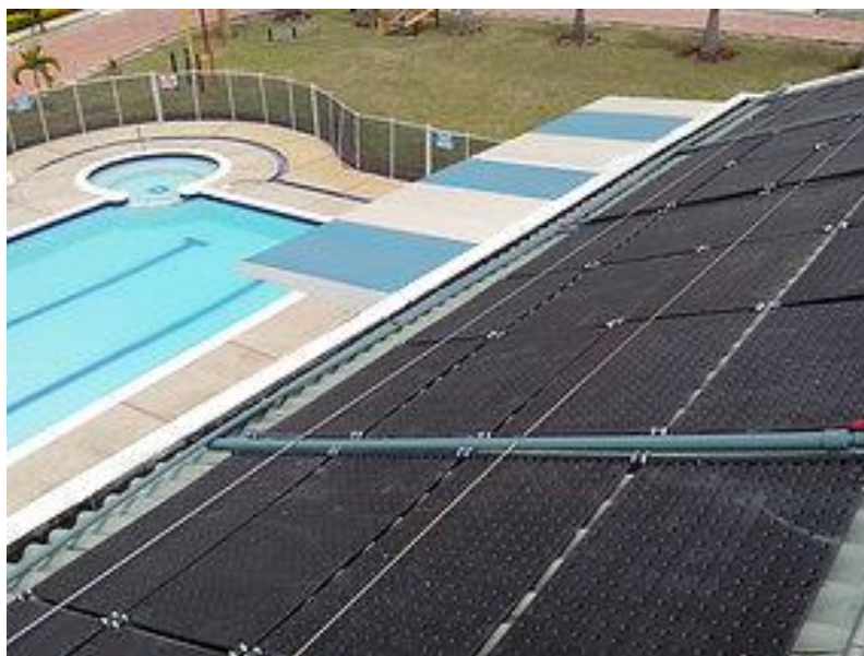
Figura 153. Calentadores solares en Conjunto Residencial Las Heliconias. Fuente: http://www.soefi.com.co/calentador-solar-piscinas?lightbox=imageudz
