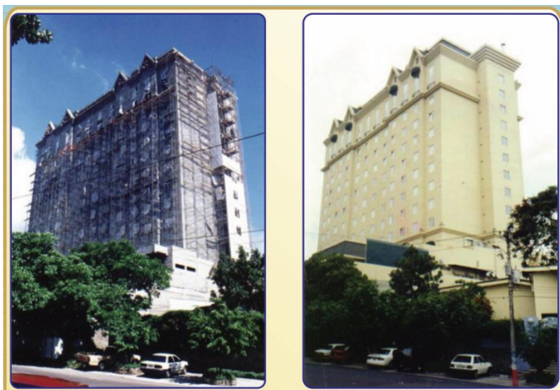
Figura 129. Construcciones con convitec Fuente: Manual técnico COVINTEC.
