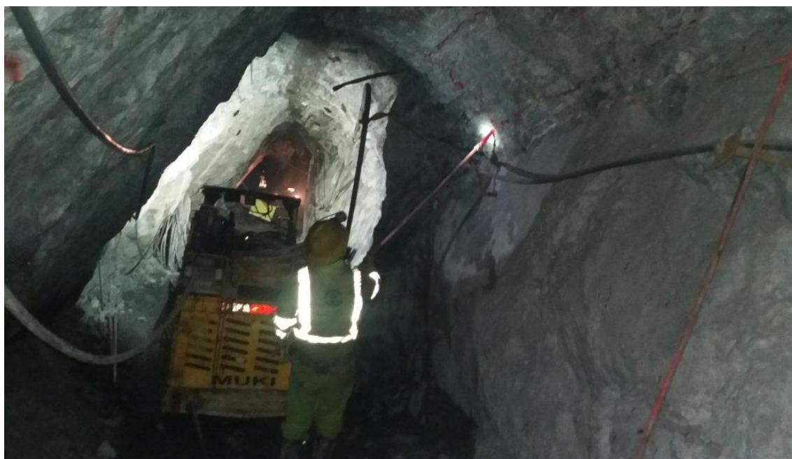
Figura 2: Malla de perforación pintada
