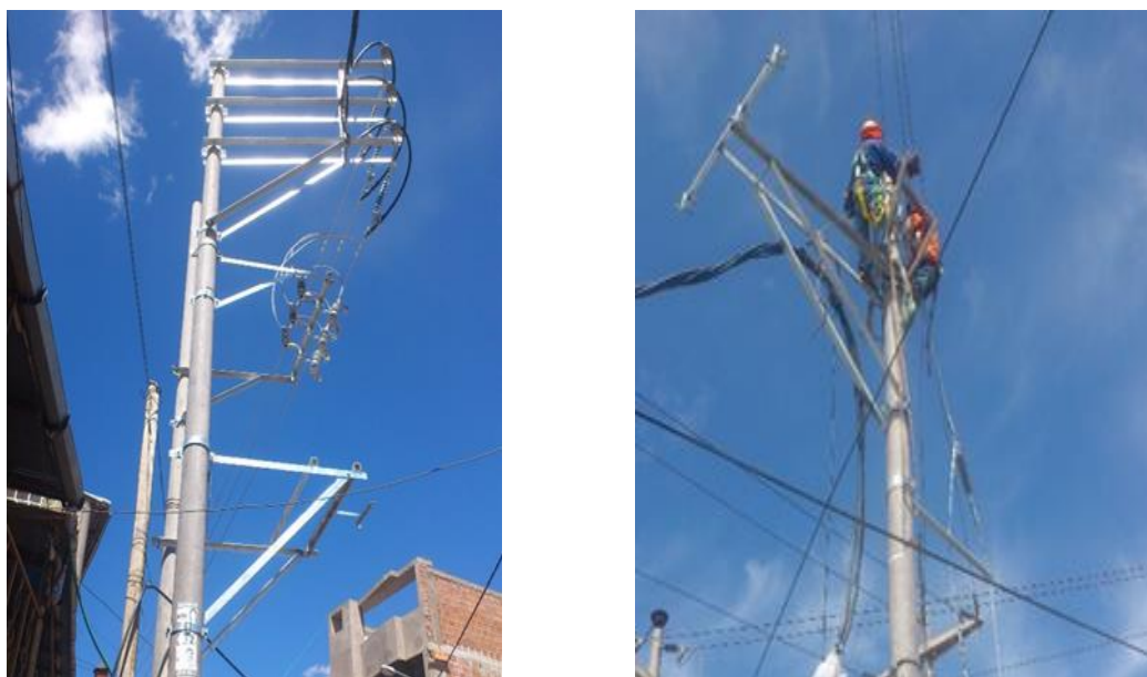
Figura 30. Instalación de Armados y Equipos de Protección.
