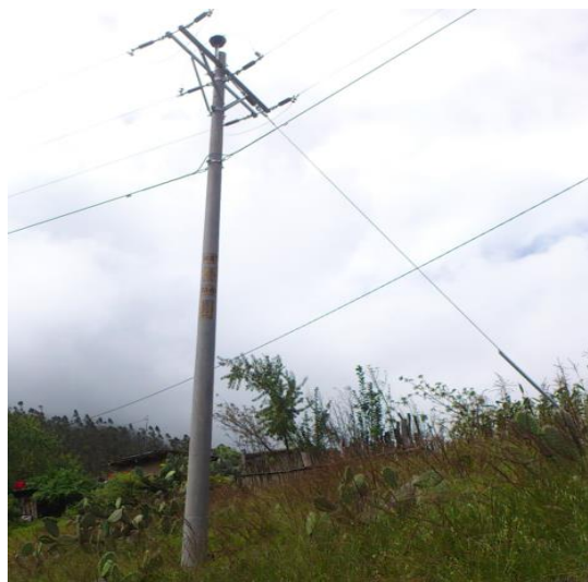
Figura 8. Estructura en Anclaje.
