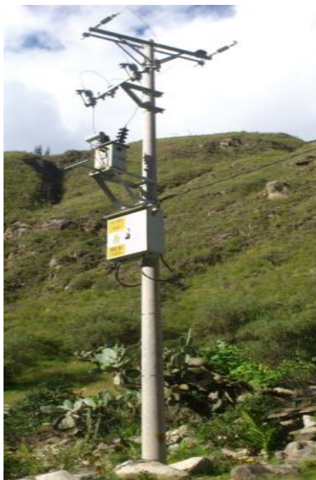
Figura 9. Estructura Fin de Línea.
