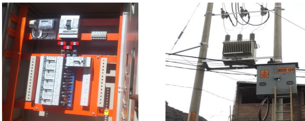
Figura 37. Instalación del Tablero de Distribución.
