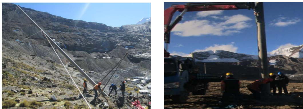
Figura 28. Izaje de postes mediante grúa y manual.
