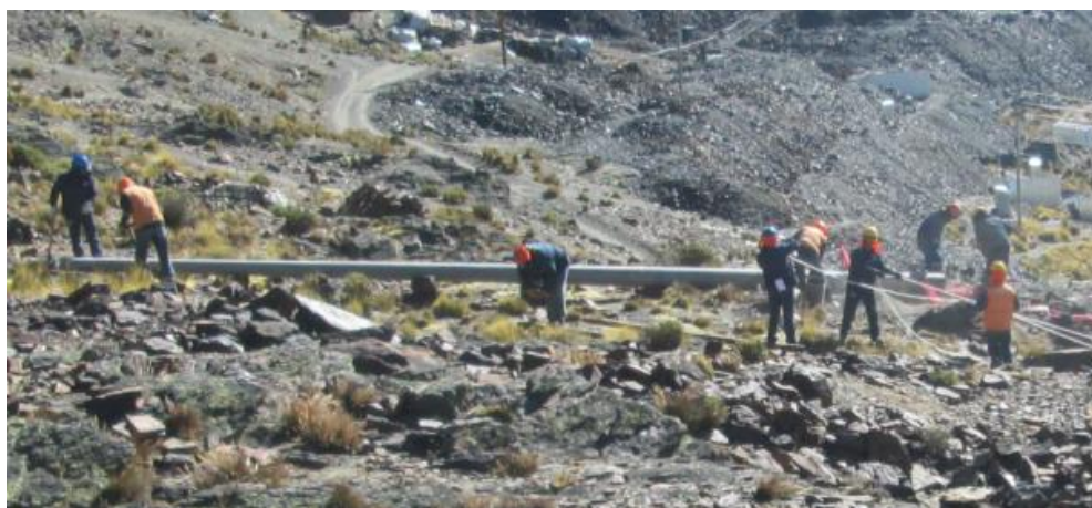
Figura 27. Traslado del poste desde almacén hasta punto de Izaje.
