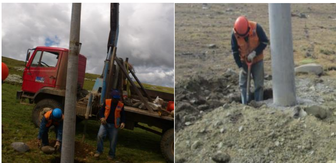
Figura 29. Cimentación de poste, acabado y limpieza.
