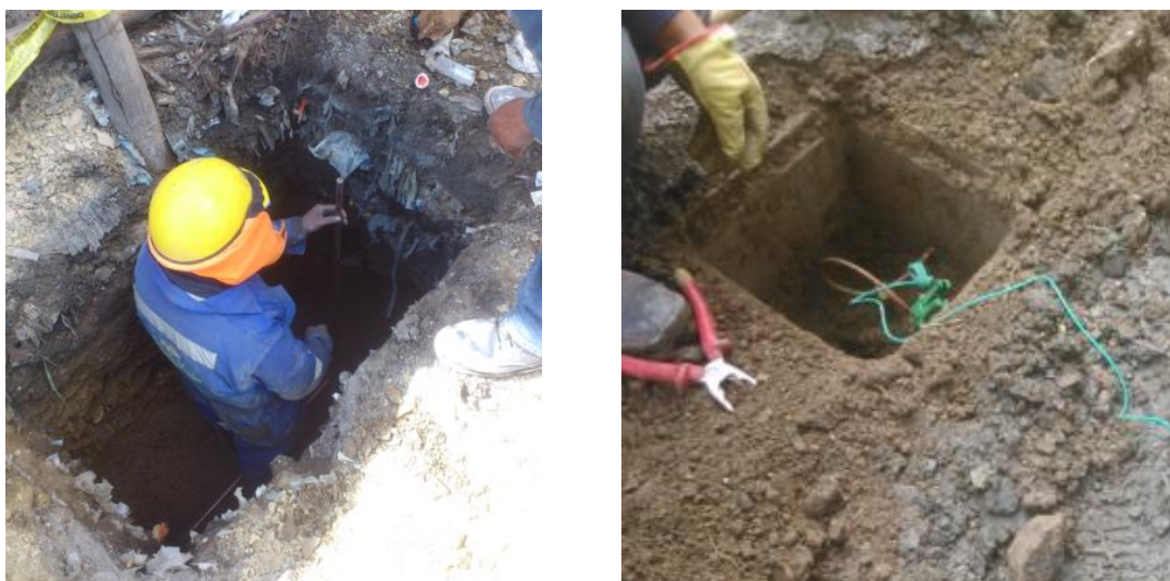
Figura 35. Excavación, Tratado y medición de Puesta a Tierra.
