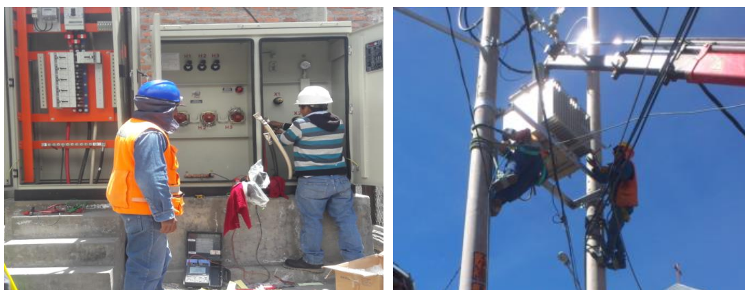
Figura 36. Montaje del Transformador de Distribución.
