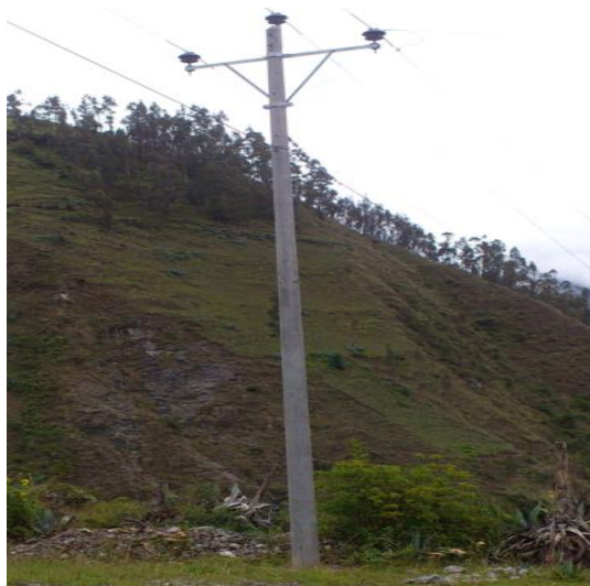
Figura 6. Armado en Alineación.
