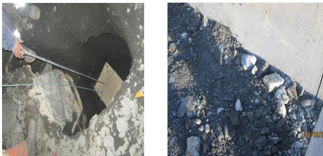
Figura 31. Apertura, Relleno e Instalación de la Retenida.
