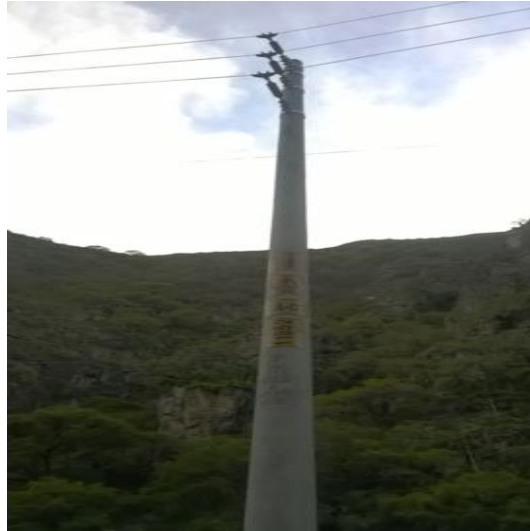
Figura 7. Estructura en Ángulo.
