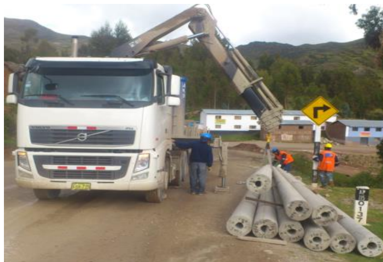
Figura 26. Descarga de los postes en el sitio de la obra.
