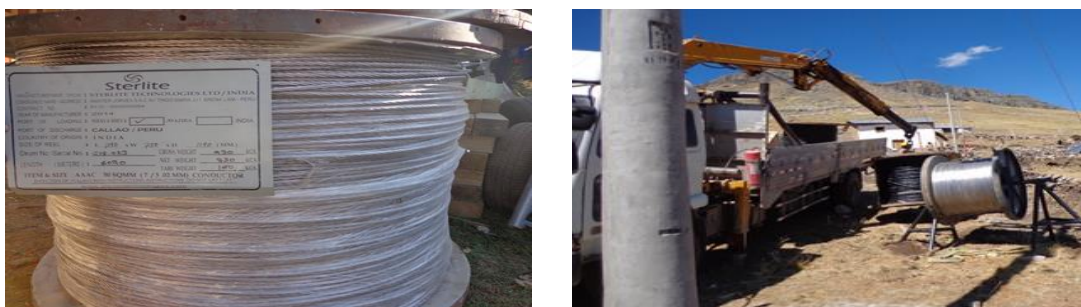
Figura 32. Carga y Descarga de Conductor en Grúa.
