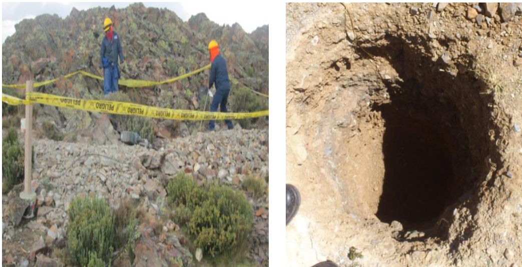
Figura 25. Excavación de hoyo para Izaje de poste.
