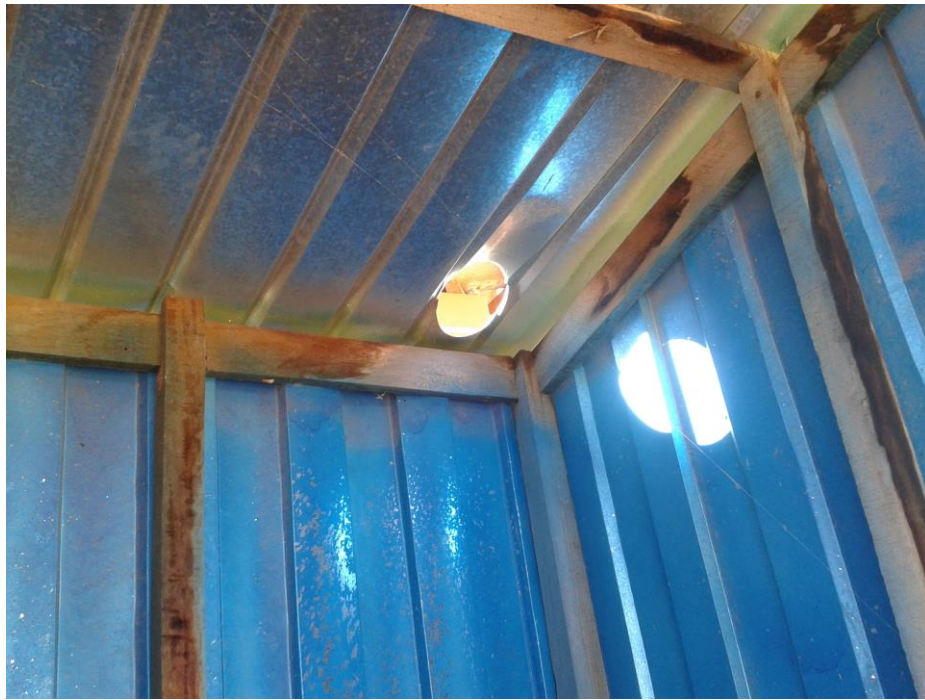
Descripción: Estado actual de UBS
