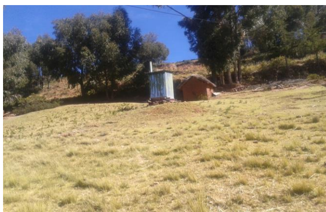
Figura 7: UBS ubicadas en zona no inundables
