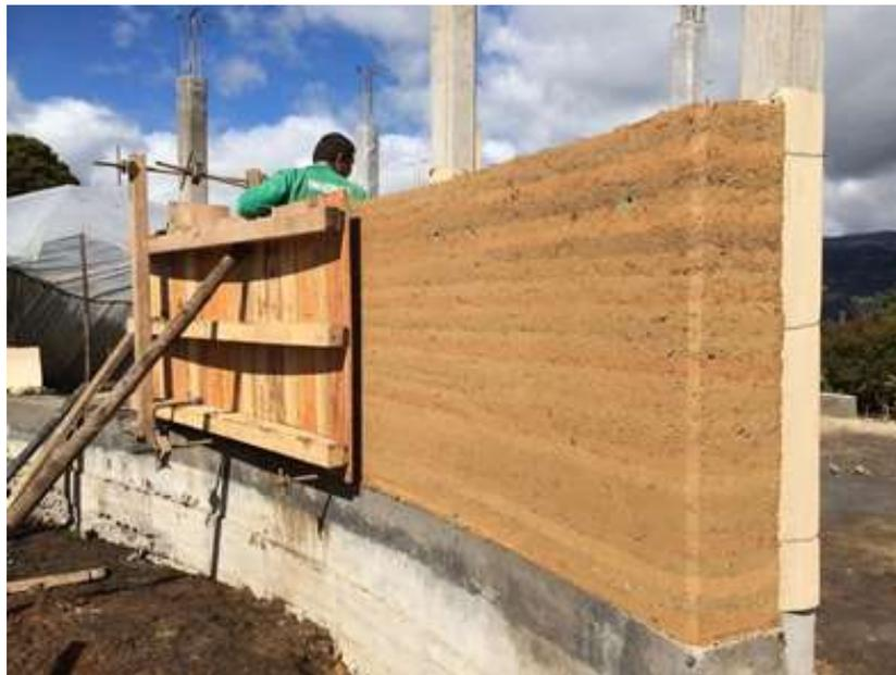
*Figura 11: Muros de Tierra Armada*
