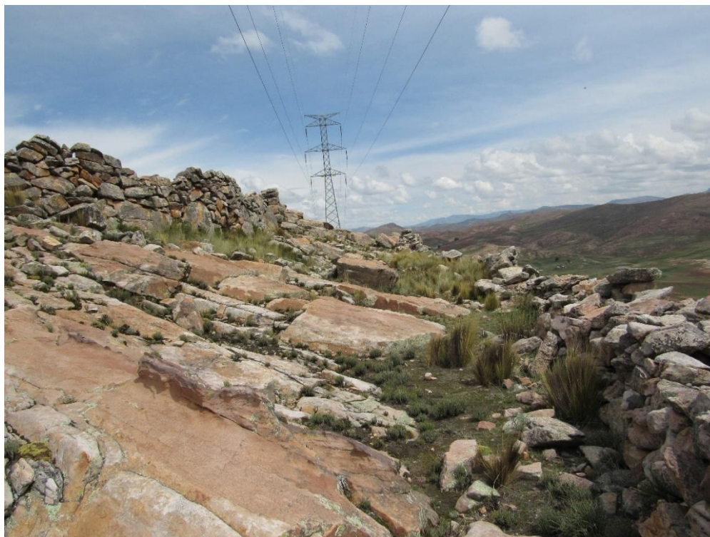
Figura 16 , murallas de Cajro – Chacocunca en un estado de conservación malo y con instalación de redes de tensión eléctrica que pasan por encima del sitio.
