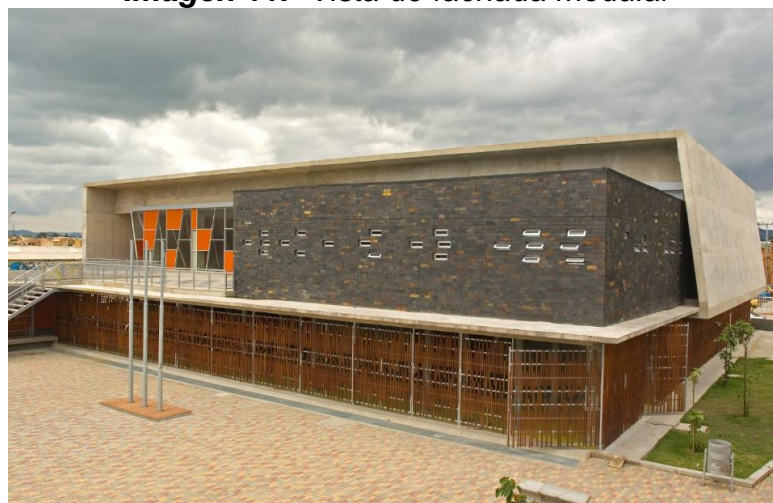
Imagen 11.- Vista de fachada modular
