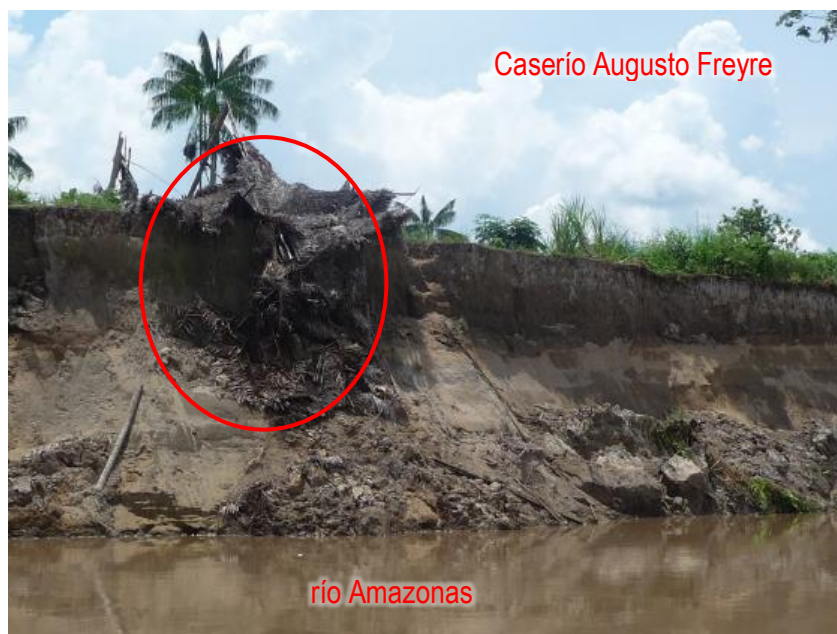
Figura 73: Vivienda desplomada por la erosión del río Amazonas.
