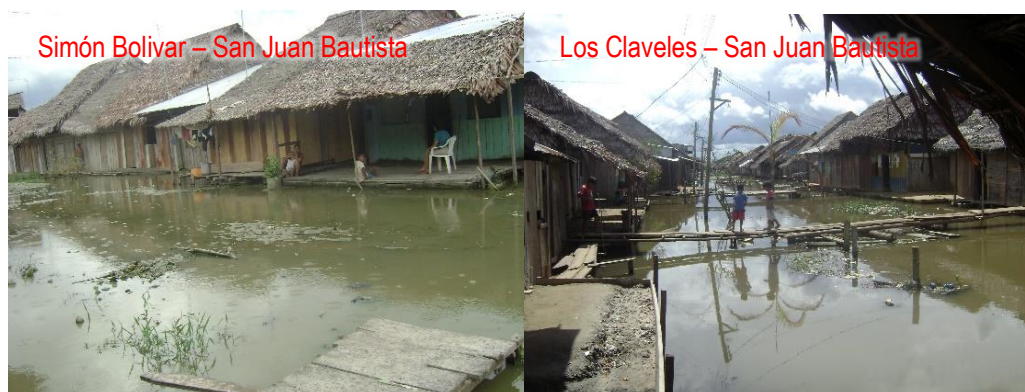
Figura 64: Viviendas afectadas por inundación, en San Juan Bautista (INDECI, mayo 2009).
