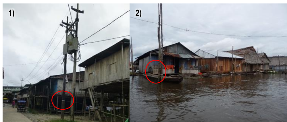
Figura 90: Marca de agua que dejó en los postes la inundación.
