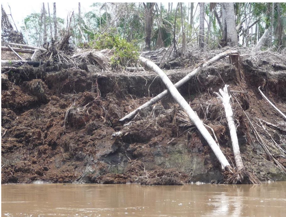
Figura 71: Erosión fluvial, margen derecha del río Nanay, Sector Padre Cocha.
