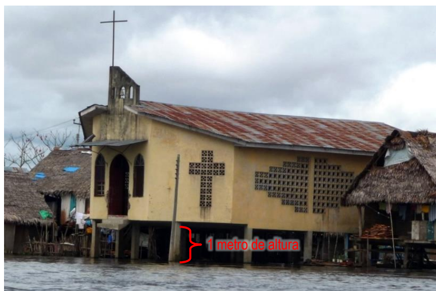
Figura 68: Iglesia construida por encima del nivel de inundación esperada, Belén (Medina, et al 2009).
