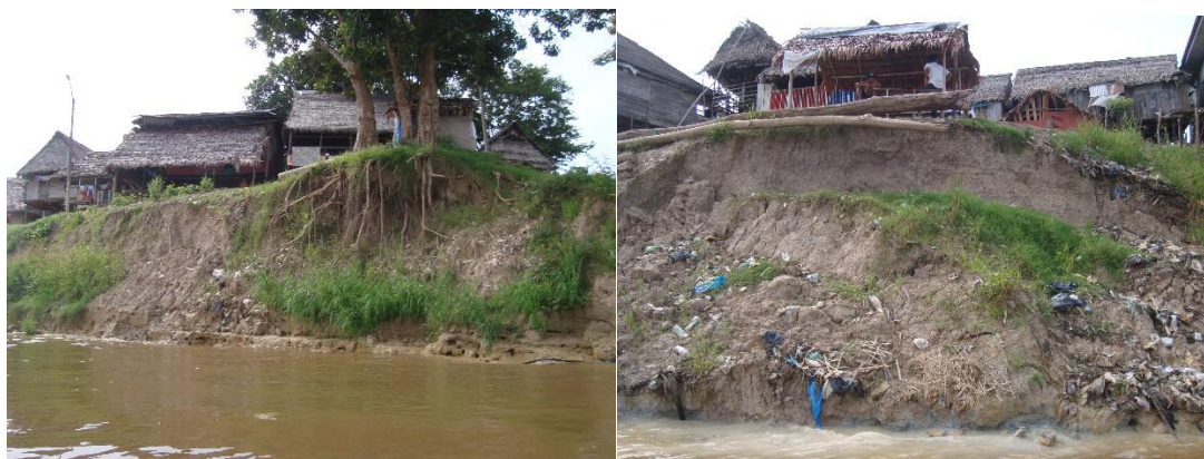
Figura 70: Viviendas al borde de erosión fluvial – Caserío San Francisco, Belén.
