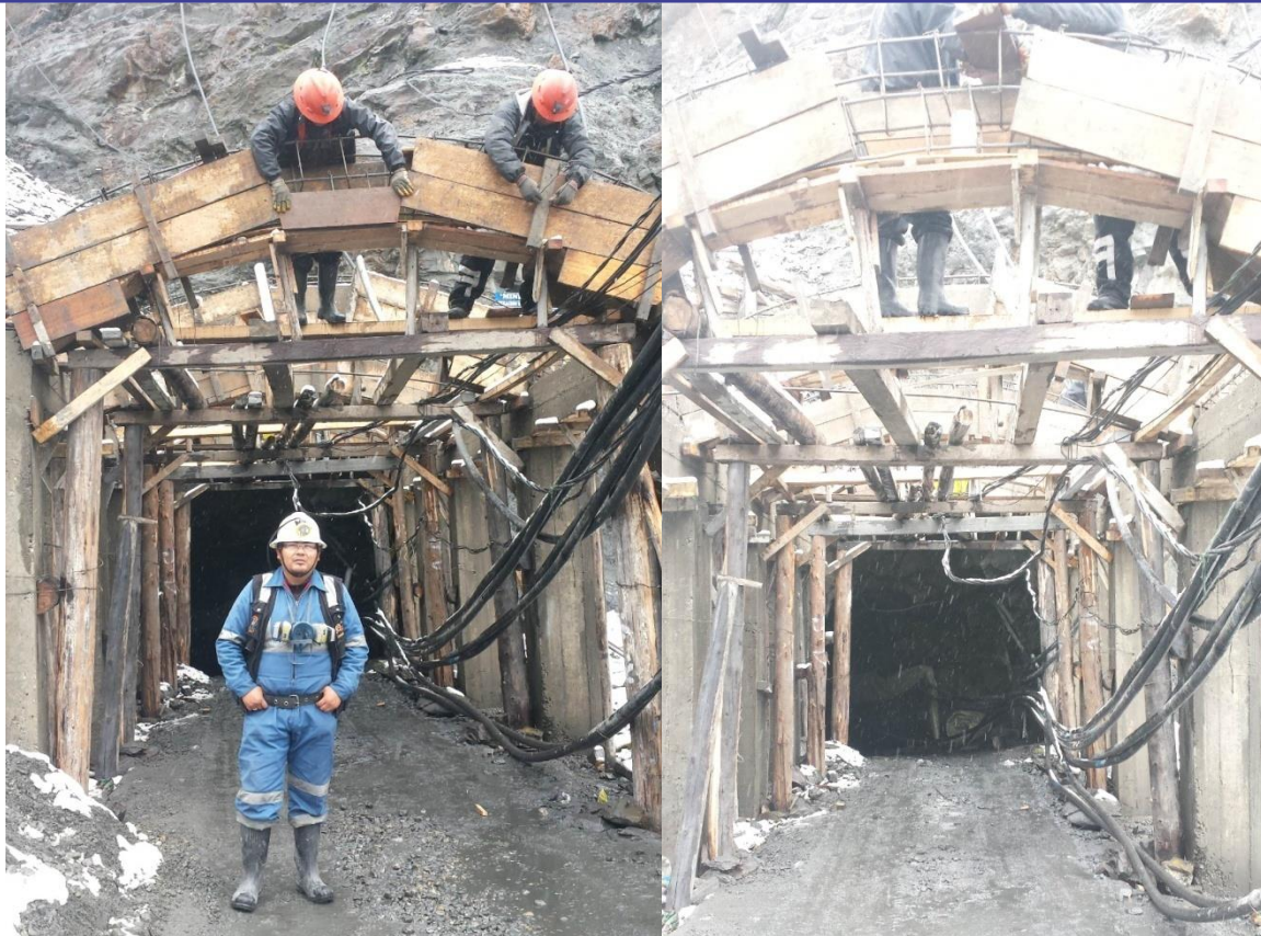
Figura 5.1 Procesos de construcción del falso túnel Fuente: Elaboración propia
