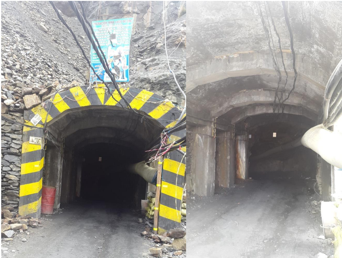
Figura 5.3 Vista exterior e interior del túnel falso Fuente: Elaboración propia
