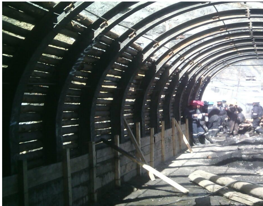
Figura2.2 Ejemplo de obras de protección
