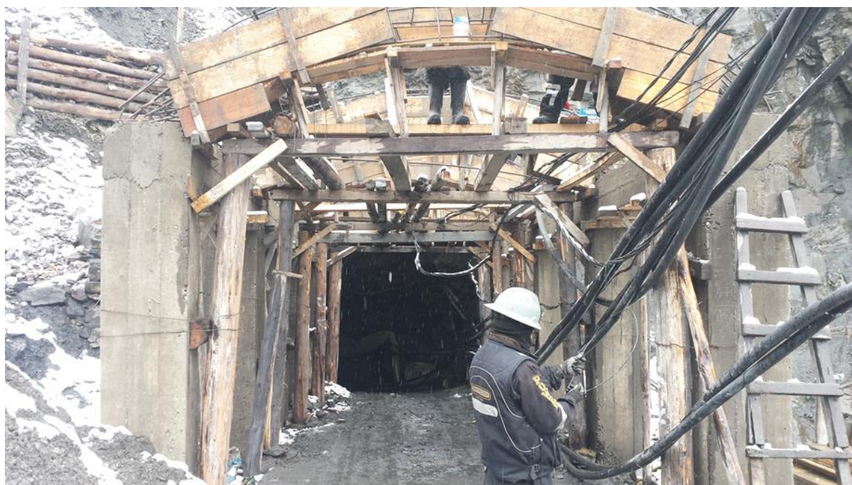
Figura 4.12 Armado de techo protector tipo baúl
