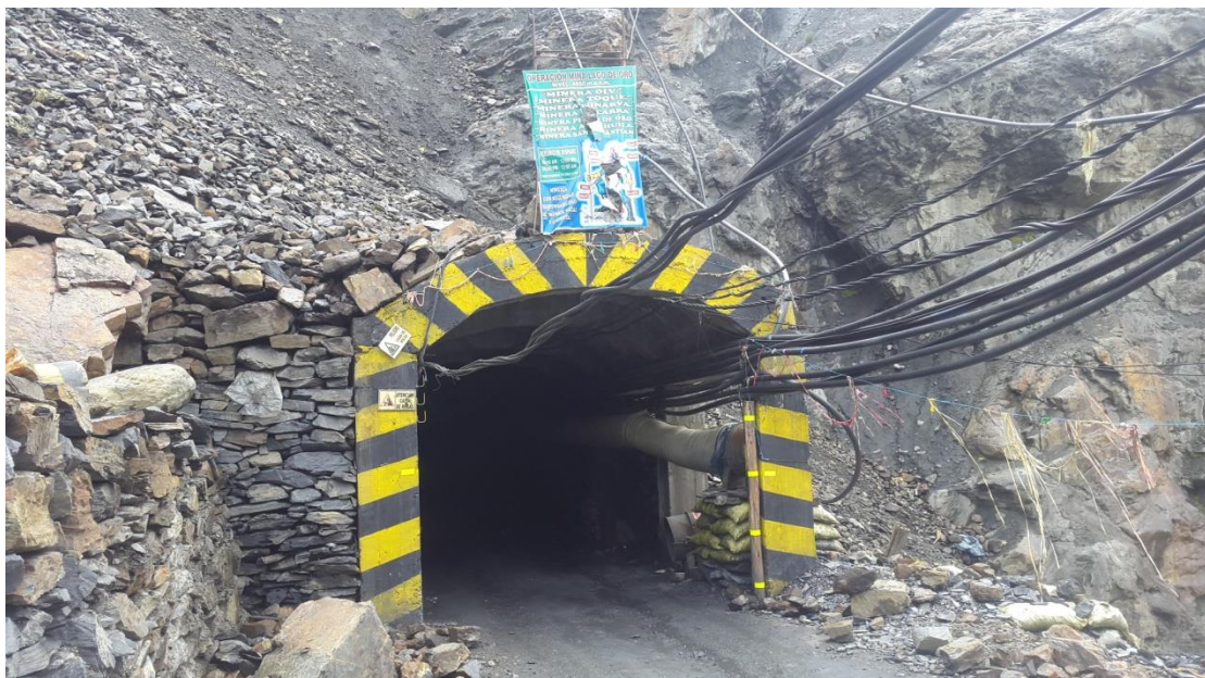
Figura 5.2 término de la construcción del falso túnel Fuente: Elaboración propia
