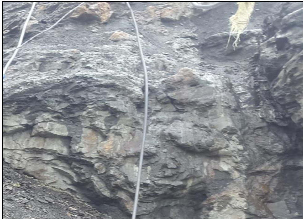
FOTOGRAFIA DE LA ESTACIÓN GEOMECÁNICA
