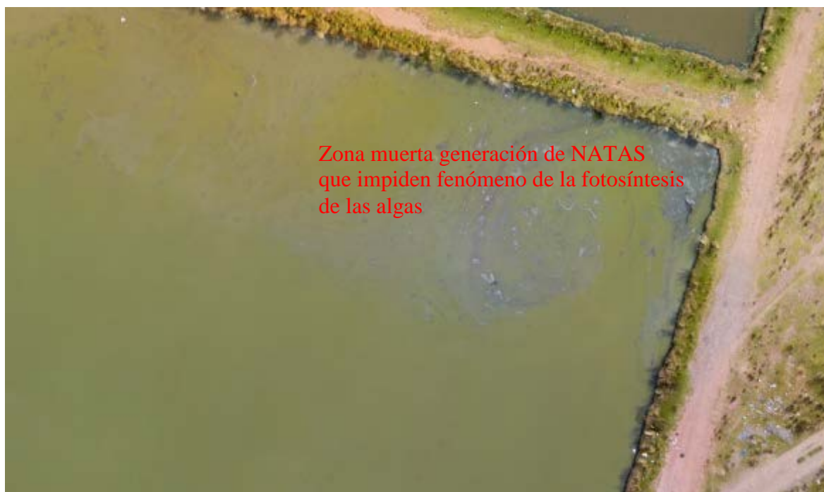
Figura 98.- Cortó circuito en laguna 01
