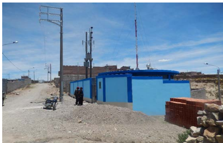
Figura 51.-Caisson De Aguas Servidas N° 05 “Rio Blanco”
