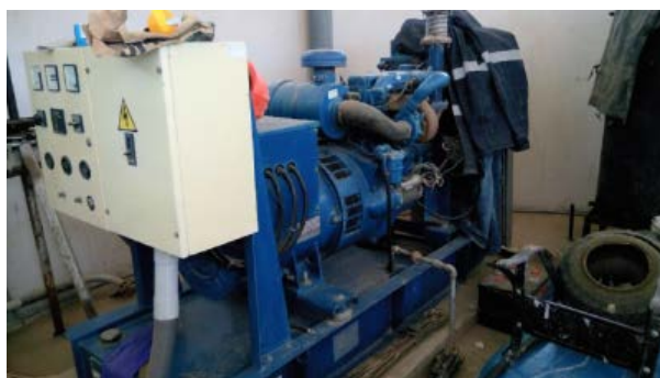
Figura 44.-Equipamiento De La Cámara De Bombeo De Aguas Residuales San Francisco De Borja Fuente propia. Foto tomada 06/06/2017.
