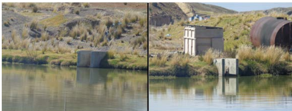
Figura 89.- Estructura de salida de laguna 02,01
