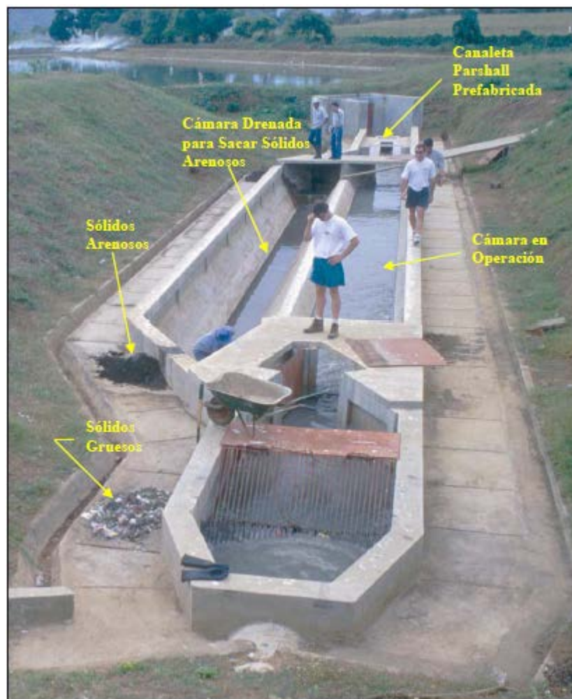
Figura 18.- Mantenimiento de un desarenador
