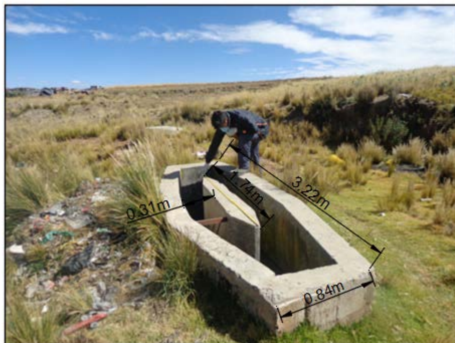
Figura 78.- Cámara de Rejas Medidas.
