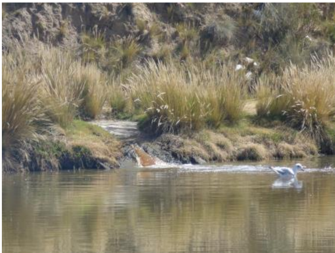
Figura 88.- Estructura de Entrada a la Laguna 02.
