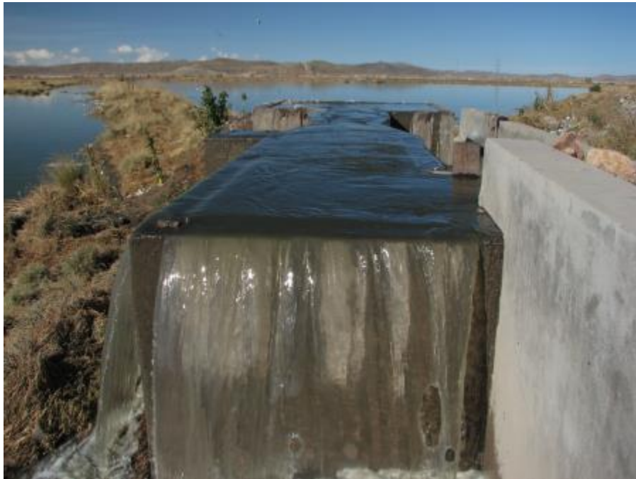
Figura 109.- Repartidor de Caudal, Ptar Juliaca. Visita técnica.
