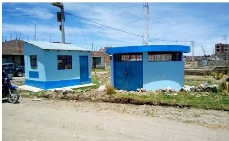
Figura 43.-CAISSON DE AGUAS SERVIDAS N° 01 “SAN FRANCISCO DE BORJA” Fuente propia. Foto tomada 06/06/2017.
