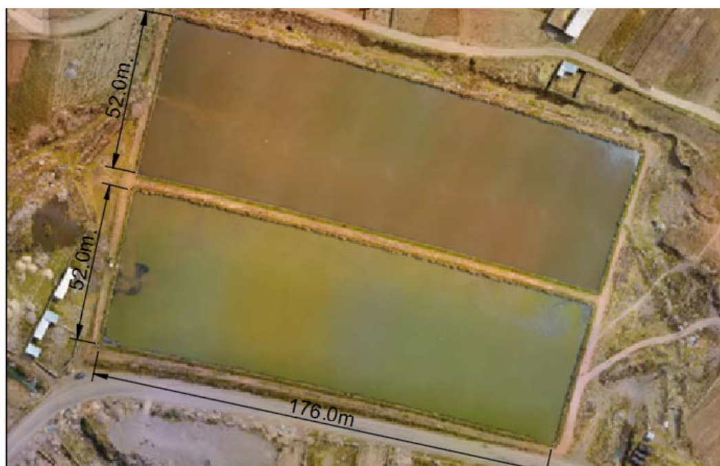
Figura 82.- Vista aérea de la laguna de estabilización. Fuente: Foto aérea tomada desde un Drone (18/05/2017). El fondo y los taludes de la laguna están impermeabilizados con arcilla de 20cm de espesor.
