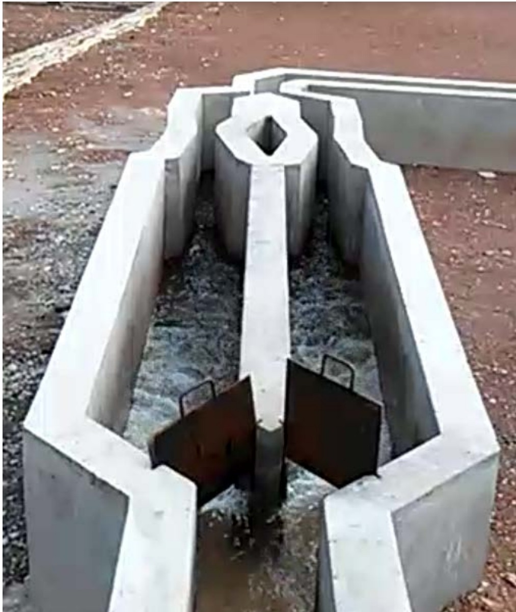
Figura 19.- Desarenador de la PTAR del Distrito de Tilali. Se visualiza en la foto un desarenador con flujo turbulento. Foto Tomada en 15/01/2015.
