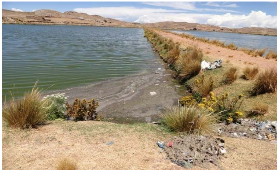
Figura 5.- Foto Laguna de estabilización de la localidad de Ilave (19/05/2017); Sólidos flotantes.
