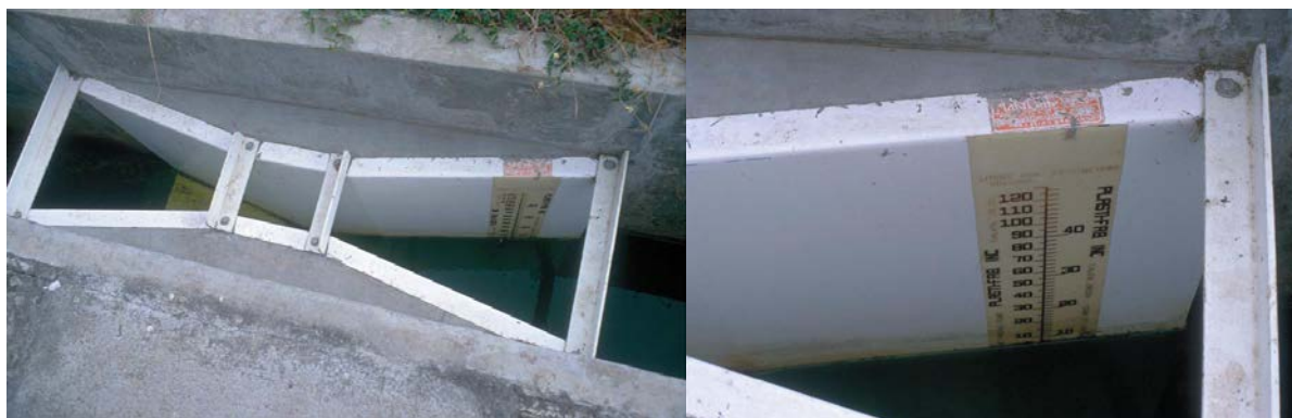
Figura 22.- Canaleta Parshall, Prefabricada.
