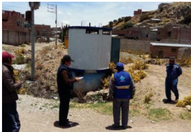
Figura 47.-Caisson De Aguas Servidas N° 03 “28 De Julio”
