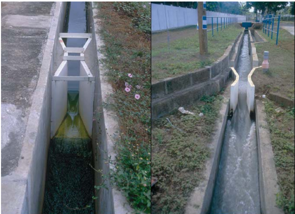
Figura 23.- Ejemplo de Canaleta Parshall Prefabricada.
