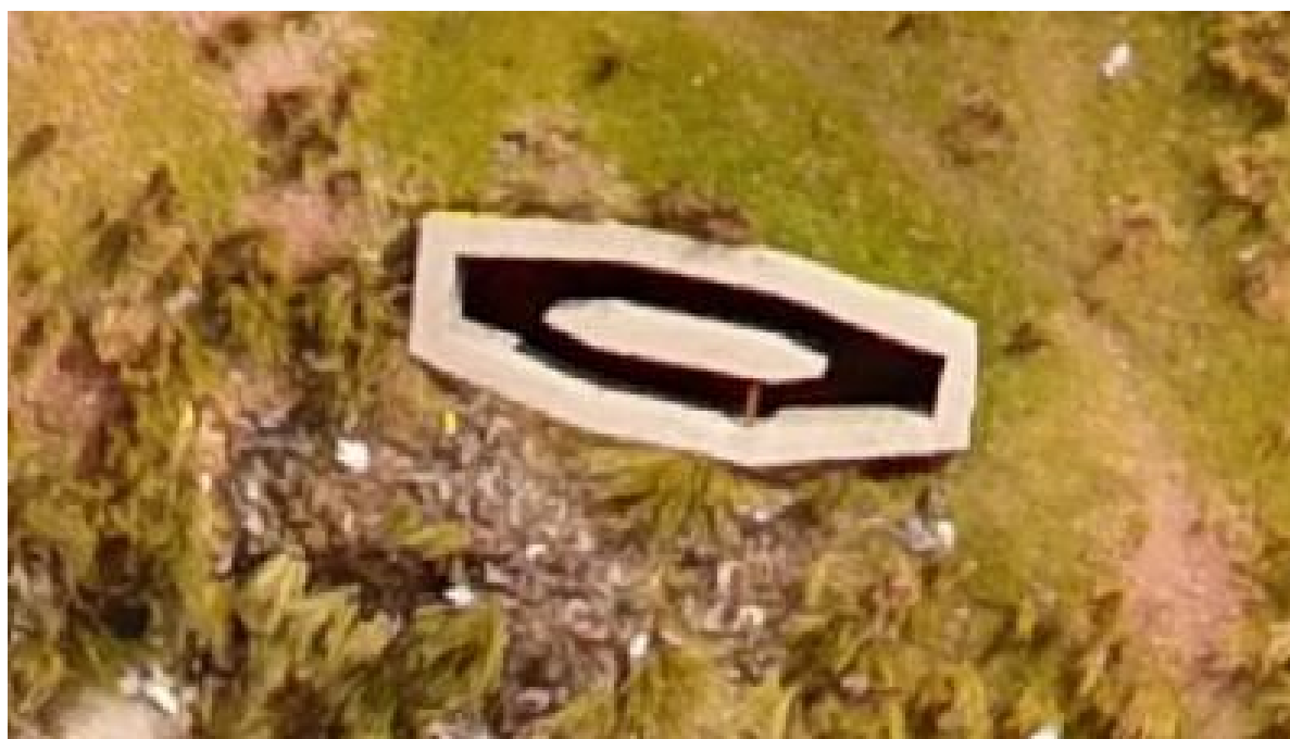
Figura 77.- Cámara de Rejas (vista en planta) Fuente: Foto aérea tomada desde un Drone (18/05/2017).
