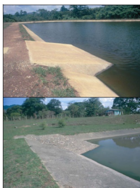
Figura 112.- Ejemplo de rampa de acceso.
