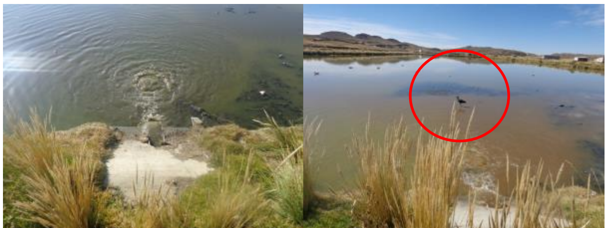
Figura 6.- Foto solidos arenosos en el ingreso de la laguna de estabilización.
