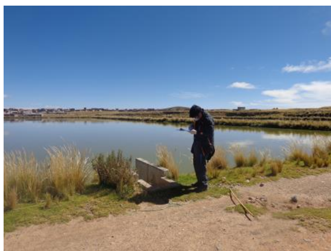
Figura 83.- Vista de la Laguna de Estabilización.
