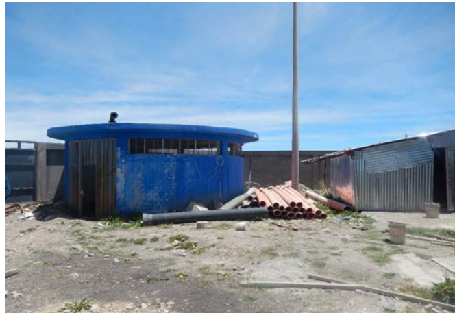
Figura 49.-Caisson De Aguas Servidas N° 04 “Caymahui”
