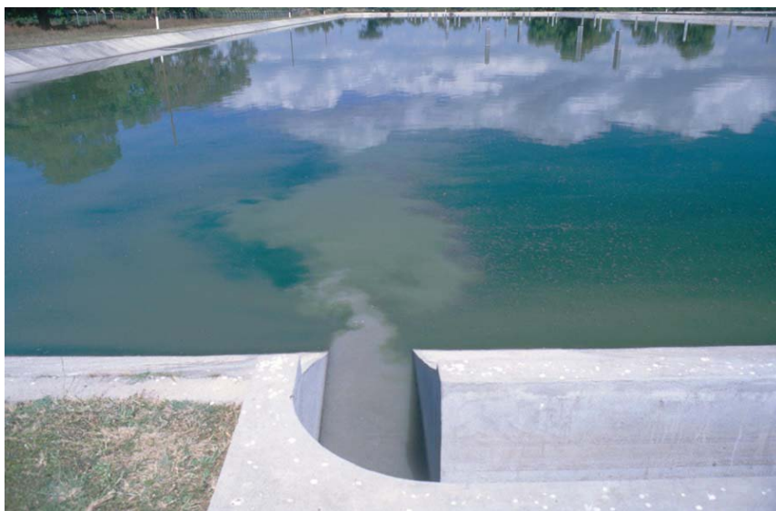
Figura 111.-Ejemplo de canal de ingreso a la laguna.
