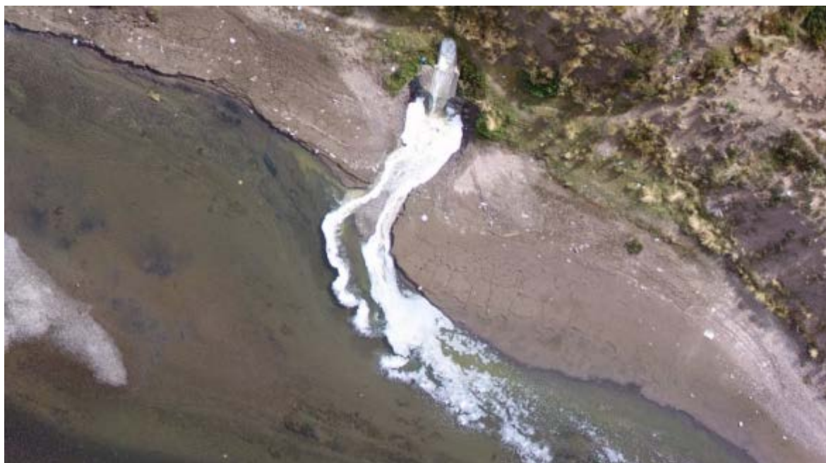
Figura 99.- Estructura de alivió, contacto de agua tratada con el cuerpo receptor.
