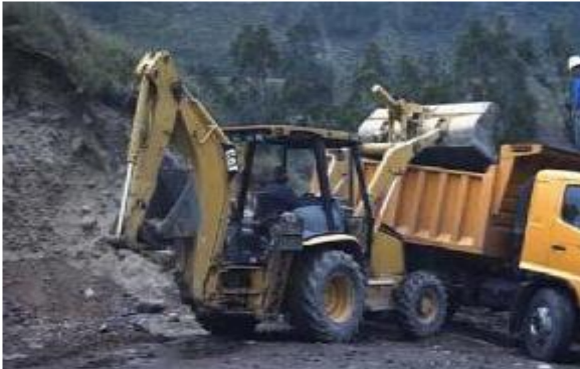
Figura 5. 8. Carguío con retroexcavadora CAT.
