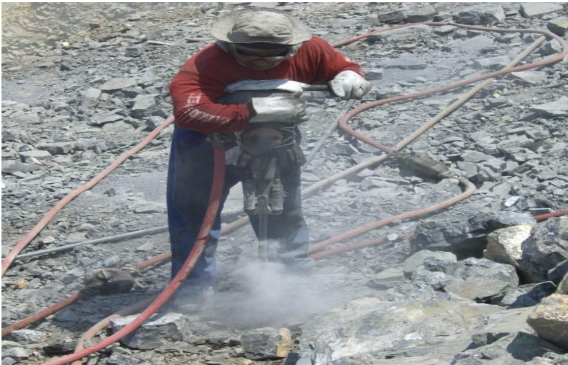
Figura 5. 1. Perforación con perforadora tipo martillo. Fuente. Autor de tesis.
