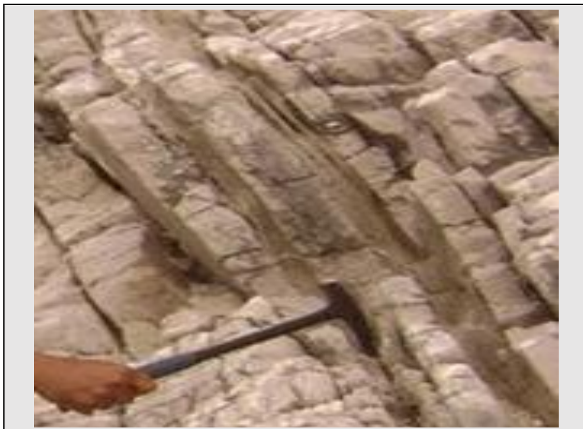
Figura 4. 10. Estructura litológica meteorizada en cantera de caliza La Unión. Fuente. Autor de tesis.
