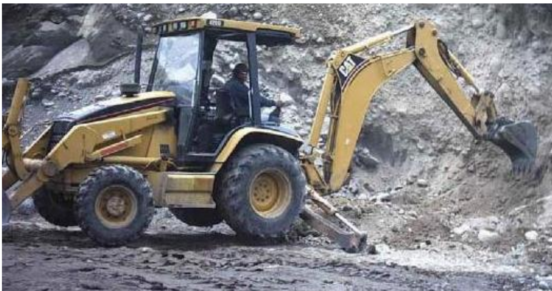
Figura 5. 7. Apilamiento con retroexcavadora CAT.
