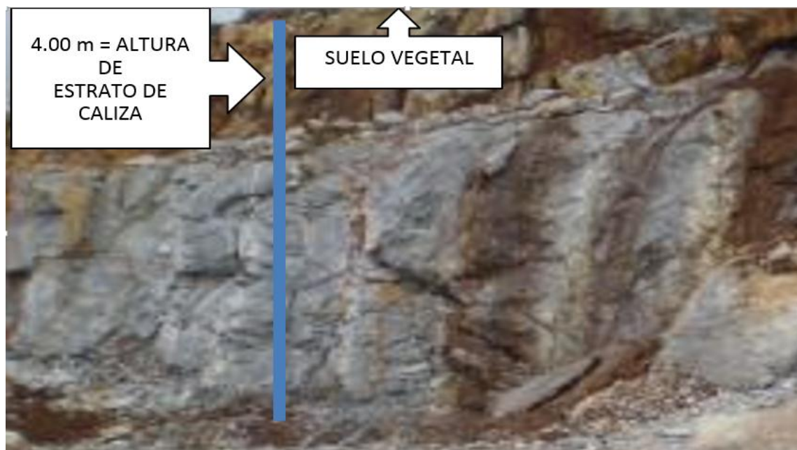
Figura 4. 8. Estructura litológica pared de banco de cantera de caliza La Unión.
