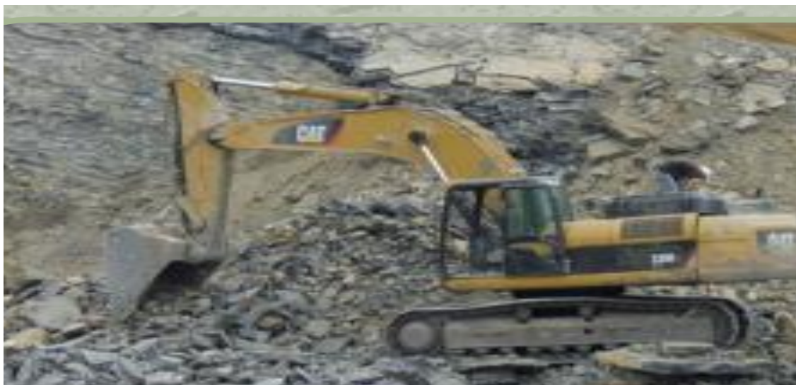
Figura 5. 51. Excavadora CAT 325DL.
