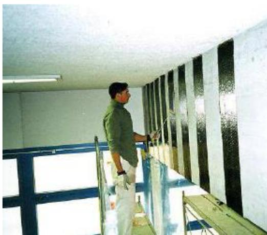
*Figura 2. 24 Aplicación del reforzamiento a cortante para reforzamiento utilizando láminas FRP en viga (Appleton & Gomes, 2007)*
