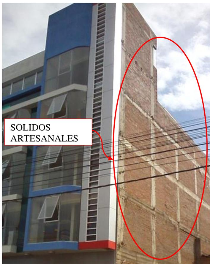
*Figura 5.30: Sólidos artesanales en muros de albañilería artesanal - Edificación existente
