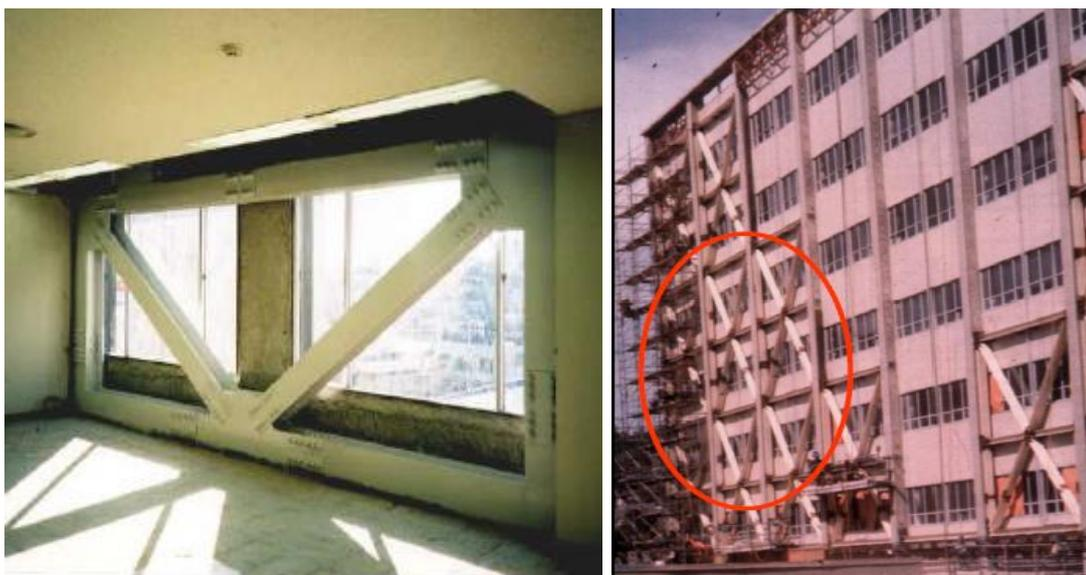
*Figura 2.7: Método de refuerzo: Diagonales o arriostres en edificaciones (Tello Malpartida, 2006).*
