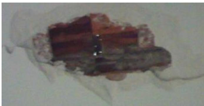
*Figura 4.7: Picado en losa h=0.20 m (Ø1/2”), para registro de armadura existente caso edificio Puno.*
