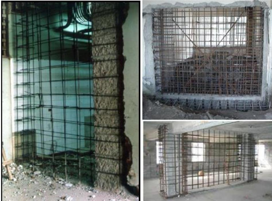
*Figura 2. 4 Método de refuerzo: inclusión de muros interiores o exteriores (O. Tello M. - 2006).*
