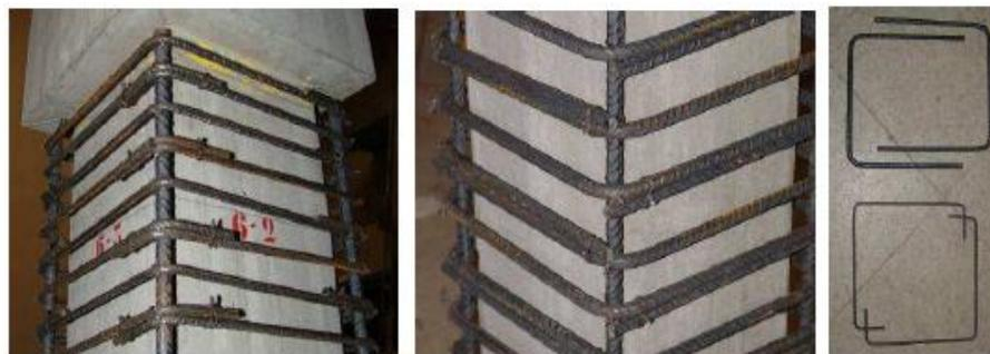
*Figura 2.21: Sistema de confinamiento en columnas con Encamisados de concreto y formas de habilitado de estribo*
