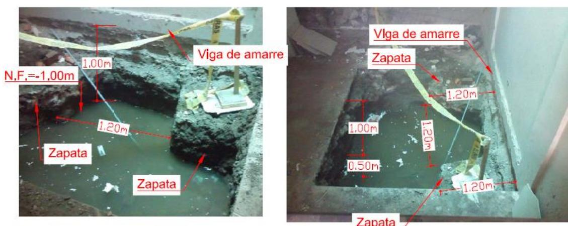
*Figura 4.1: Prospección de Zapatas existentes, se visualiza nivel de agua – Edificación Puno.*
