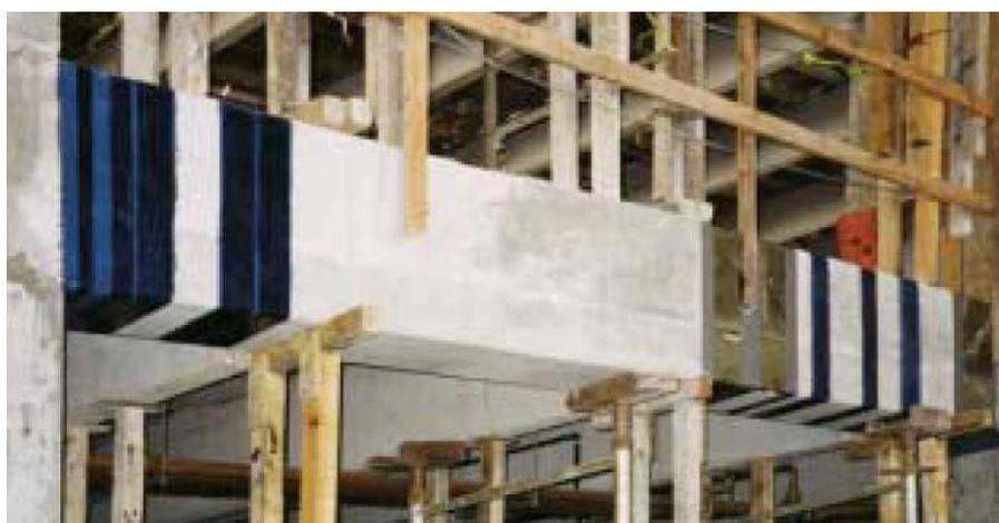
*Figura 2. 25 Aplicación del reforzamiento a cortante para reforzamiento utilizando láminas FRP en viga.*
