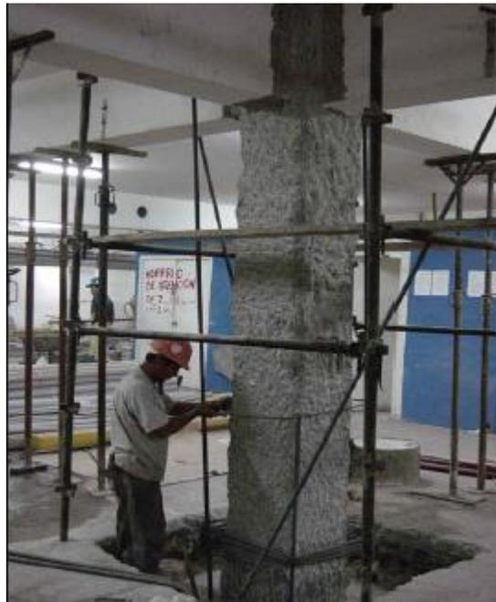
*Figura 2.20: Preparación de la superficie en encamisados de columnas (Tello Malpartida, 2006)*
