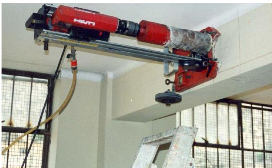
*Figura 2. 34: Equipo de perforación para la extracción de núcleos.*
