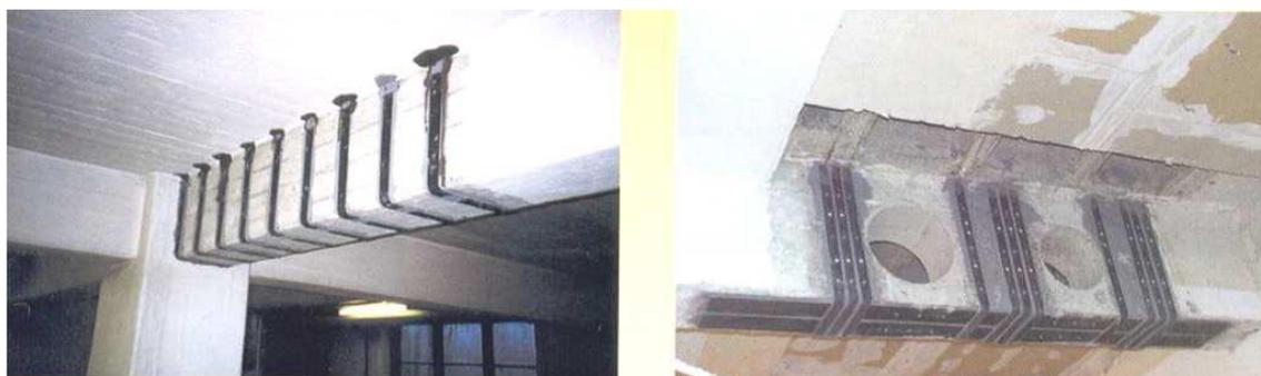
*Figura 2. 26: Aplicación del reforzamiento a cortante y flexión (Derecha) para reforzamiento utilizando láminas FRP en viga.*
