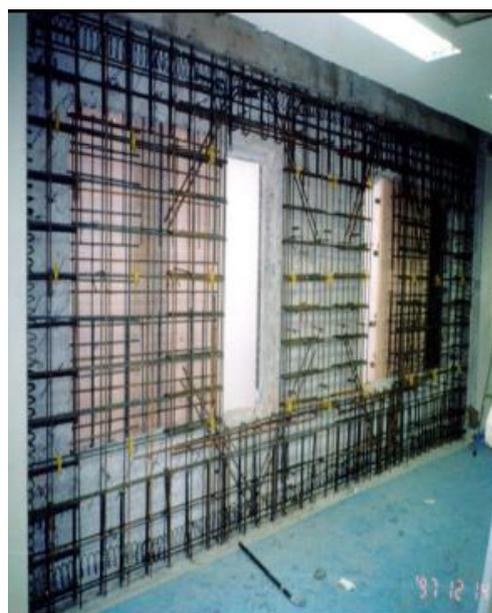
*Figura 2.5: Adición de espesor de muros (Tello Malpartida, 2006).*
