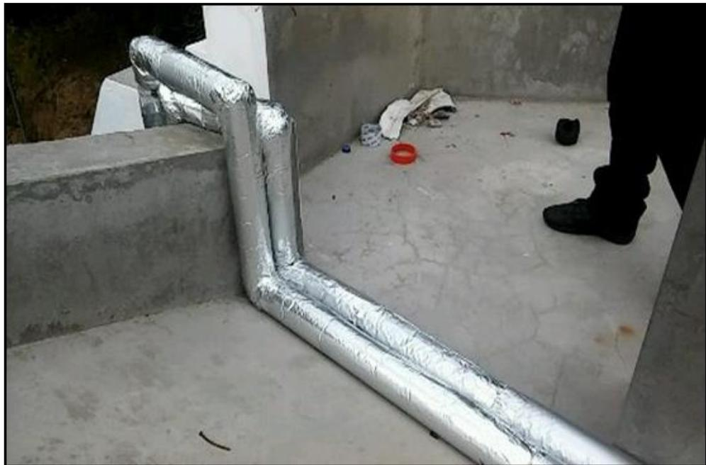
**FIGURA 04: Aislamiento de los conductos de agua caliente y frío. (UNA-FIQ).**
