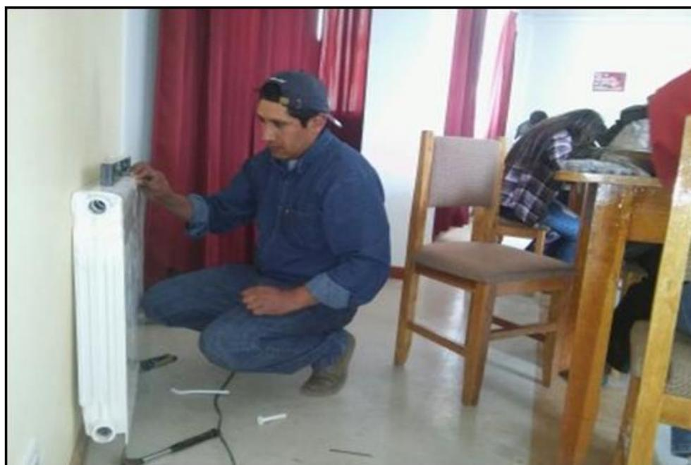
**FOTO 02: Instalación de los radiadores o disipadores de calor en el interior de la biblioteca (UNA-FIQ).**
