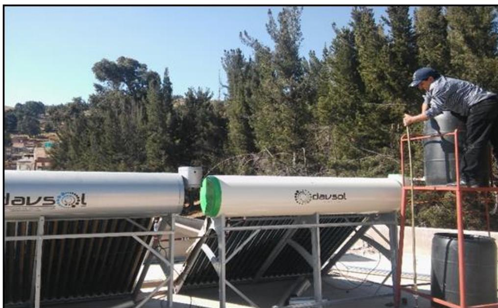
**Foto 1: Instalación de los colectores solares (UNA-FIQ).**
