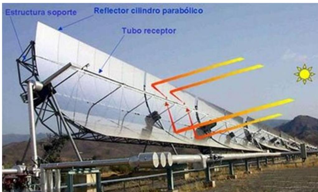
**Figura 4: Concentrador lineal parabólico**
