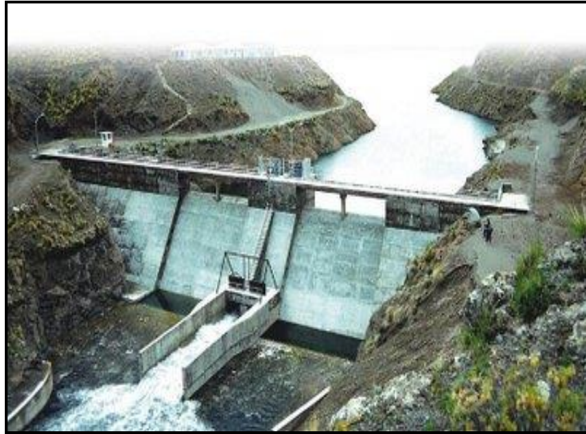
IMAGEN Nro. 08: Repesa Lagunillas, con un muro de contención de 16.2 metros de altura. Tiene una capacidad de almacenamiento de 500 millones de metros cúbicos.
