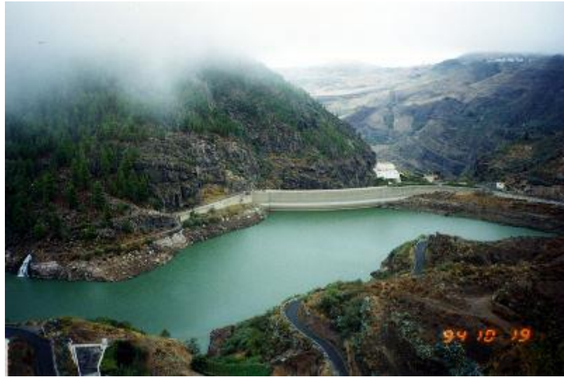
Figura 2.11. Presa de almacenamiento
