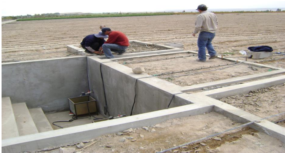
Fotografía 01: Reconocimiento y instalación de accesorios de riego a los lisímetros
