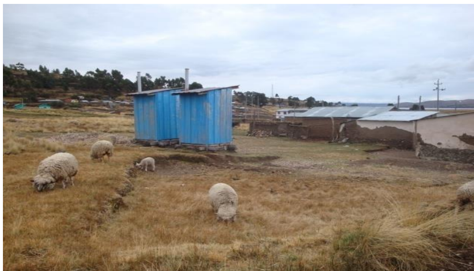
Figura N° 10: Ubicación de letrinas en función a dirección de viento.
