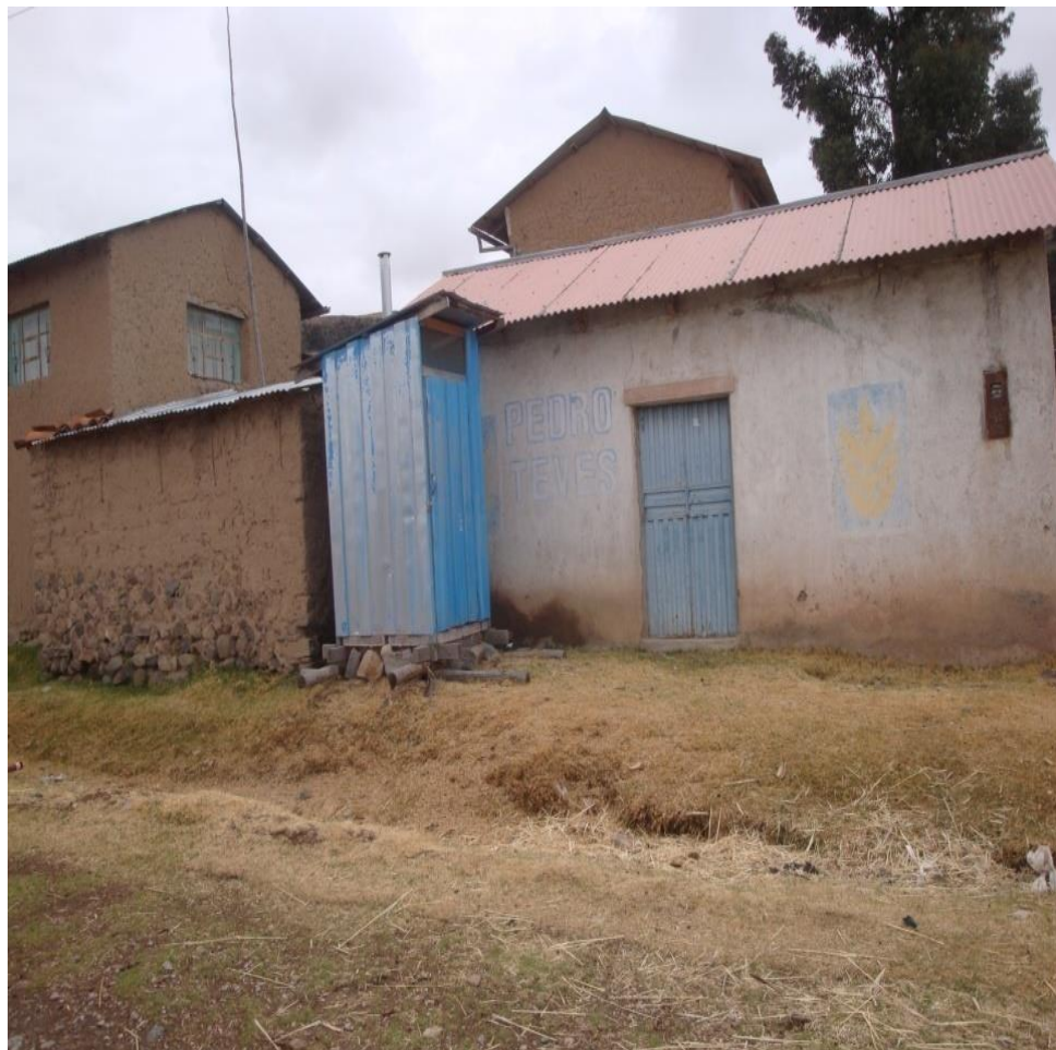
Figura N° 07: Ubicación de letrina muy cerca ala casa.
