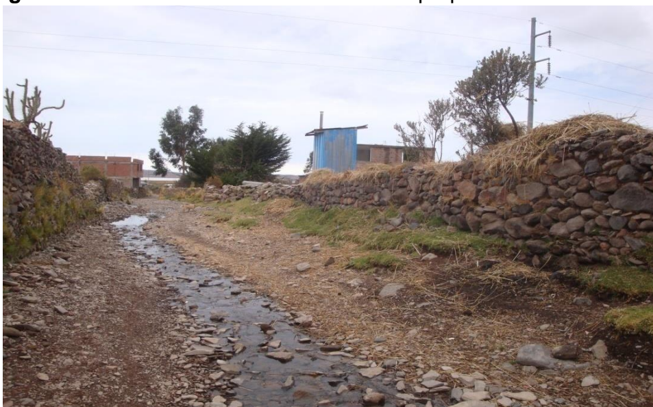
Figura Nº 09: Ubicación de letrina en zona propensa a erosión.
