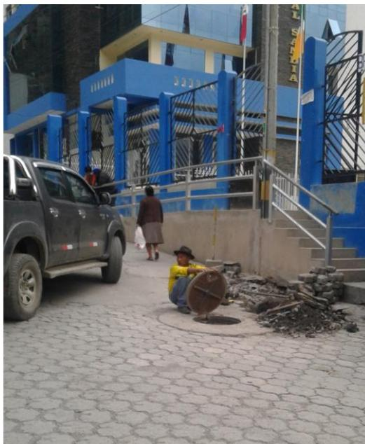
**FOTO N° 11.** Limpieza de forma manual del buzón de la red desagüe.
