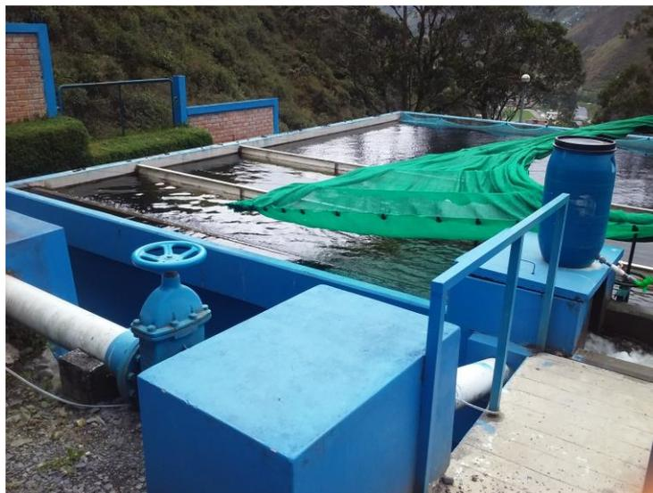
**FOTO N° 07.** Decantadores de aguas tratadas con un sistema de clorificación infraestructura en buen estado
