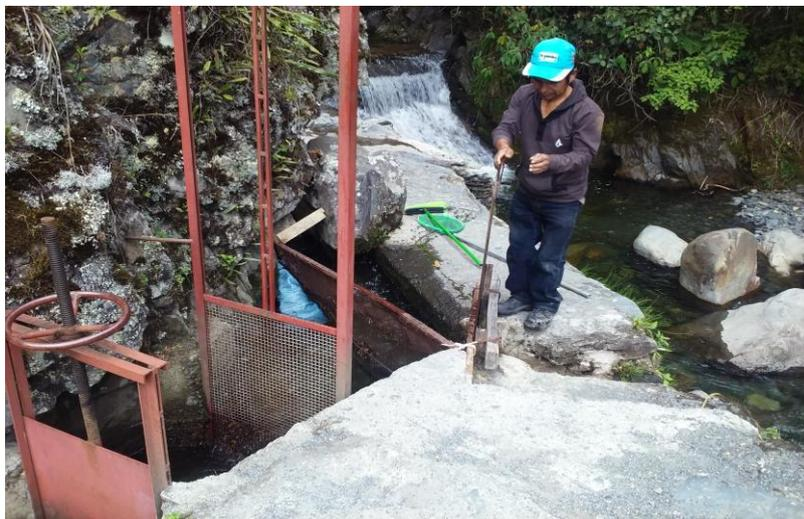
**FOTO N° 04.** Compuertas de regulación en la captación de agua para el sistema de agua potable de Sandia, en estado regular.
