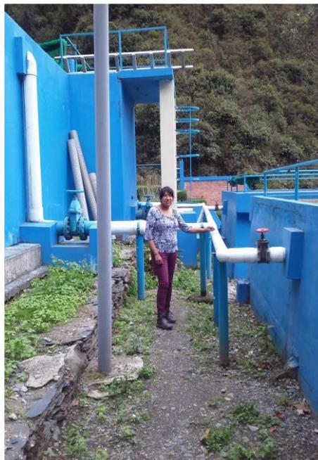
**FOTO N° 08.** Las tuberías y accesorios de la planta de tratamiento recién fueron cambiadas y se encuentran en buen estado.
