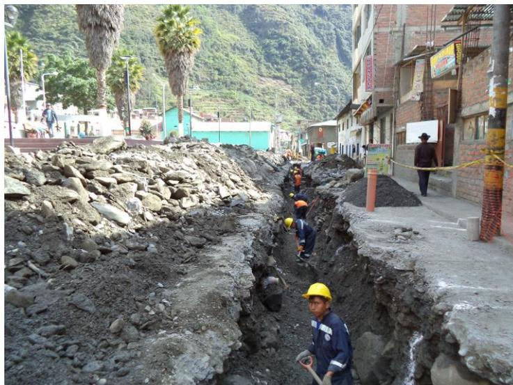
**FOTO N° 13.** Zona de grava fina con presencia de limo, arena color negro con presencia de boloneria donde se colocó las tuberías.
