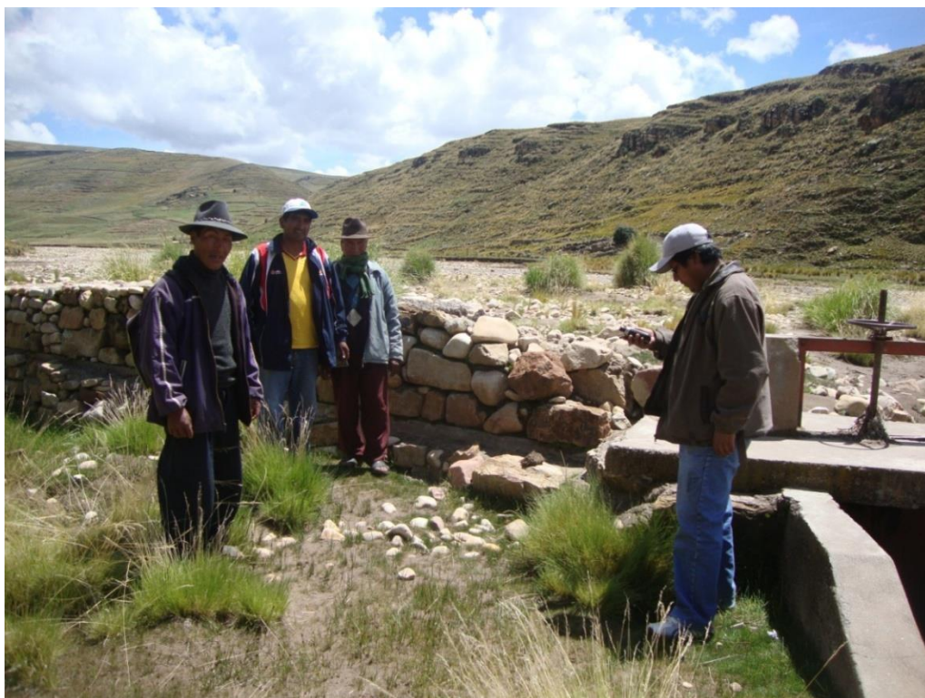
Fotografía N° 13: Reconocimiento de la bocatoma ubicada en el río Calangachi, junto a usuarios del sistema de riego.
