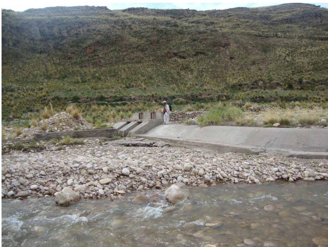
Fotografía N° 16: Vista panorámica de la bocatoma del sistema de riego.
