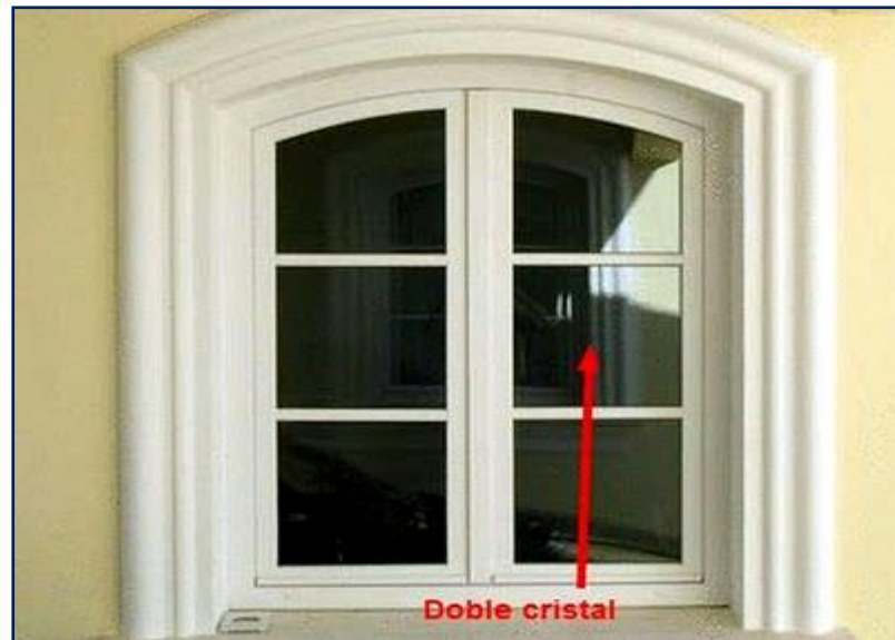
Figura N° 18: Ventana doble vidrio
