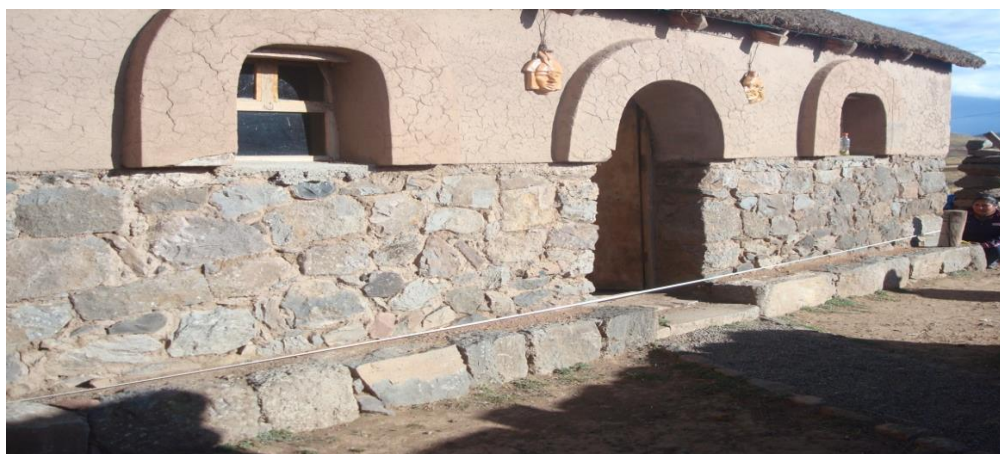
Foto. Nº 5: Medidas del dormitorio, hospedaje vivencial “Kiska wasi”
