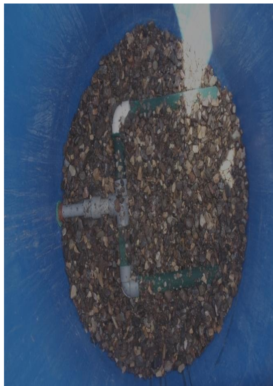
fotografía 6: colocado de grava
