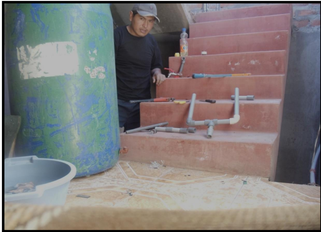
Fotografía 12: Preparación del filtro lento con los respectivos materiales
