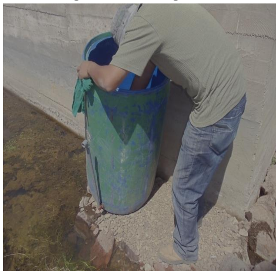
Fotografía 4: Instalación del filtro en el agua potable para el distrito de Paucarcolla del río Totorani, adaptando los cilindros en un piso estable y nivelado para que estos puedan ser utilizados adecuadamente al momento de realizar las pruebas planificadas de filtración que se realizaran posterior a esto, seguidamente una vez ya situados los
