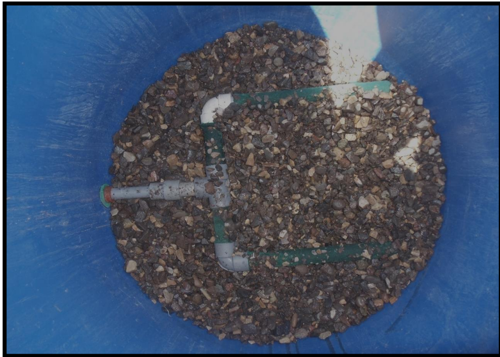
Fotografía 18: Puesta de grava en la base el filtro
