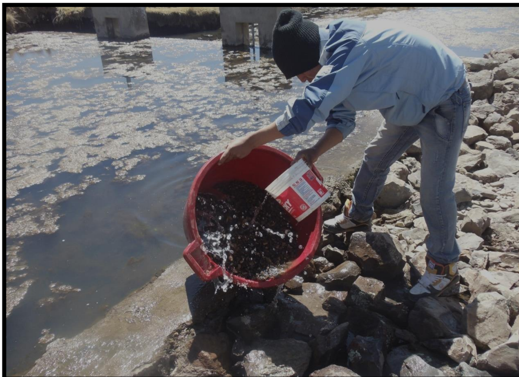
Fotografía 17: Lavado de la grava que va en la base del filtro
