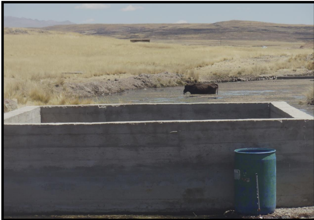
Fotografía 16: Colocado del 1er filtro de arena fina
