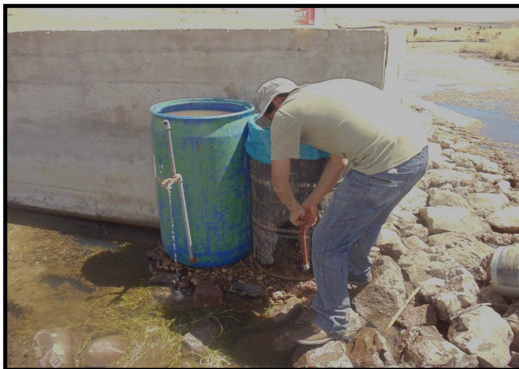
Fotografía 21: Ultimando los detalles de la instalación de los filtros
