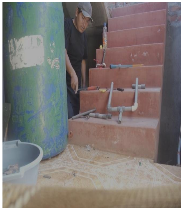
Fotografía 3: Armado del filtro lento de arena
