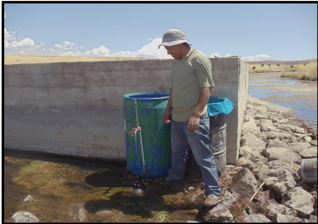
Fotografía 20: Visualizando la salida del agua del filtro
