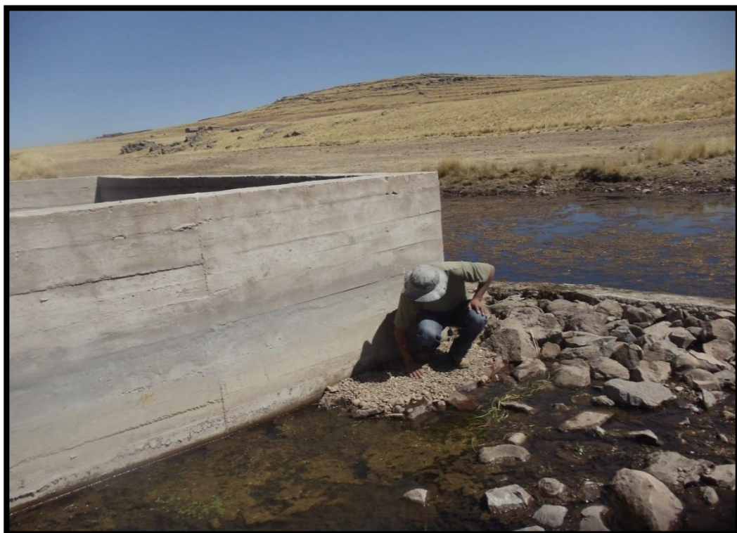
Fotografía 15: Preparación del terreno, nivelado y apisonado para la ubicación de los filtros
