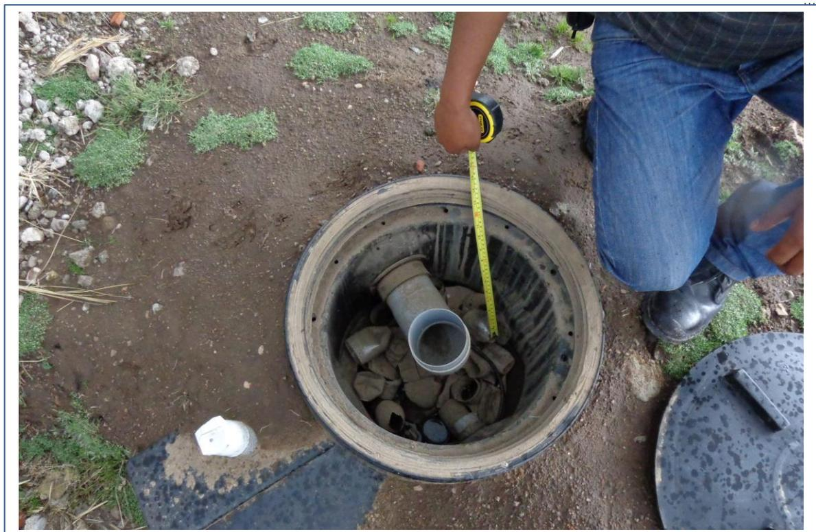
*Figura 8,* Filtro del biodigestor Alto Ayraccollana
