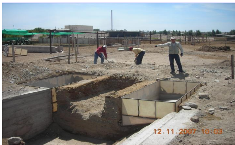
FOTO N° 01: Instalación del lisímetro en el proceso de construcción
