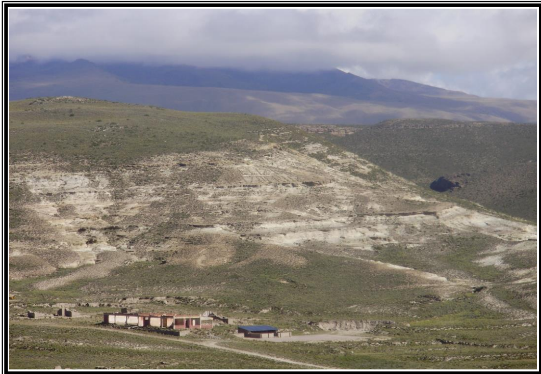
VISTA PANORAMICA DE LA PARTE ALTA DEL DISTRITO DE MAZOCRUZ EN LA CUAL SE ESTA PRESENTANDO PROBLEMAS MUY GRAVES DE EROSIÓN DE SUELOS
