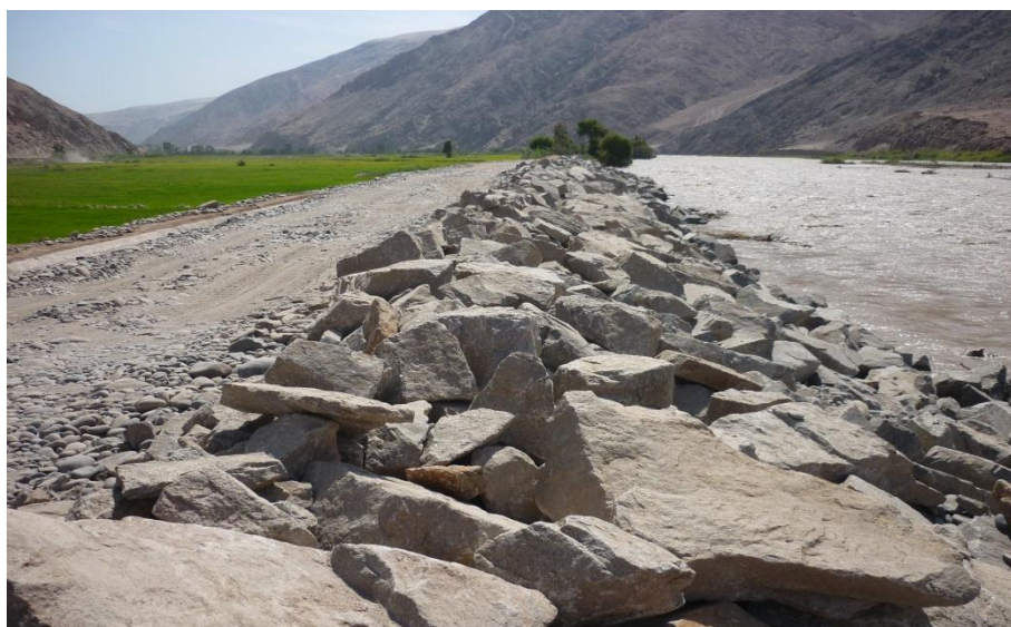
Figura 4.1.2. Enrocado al volteo del dique.
