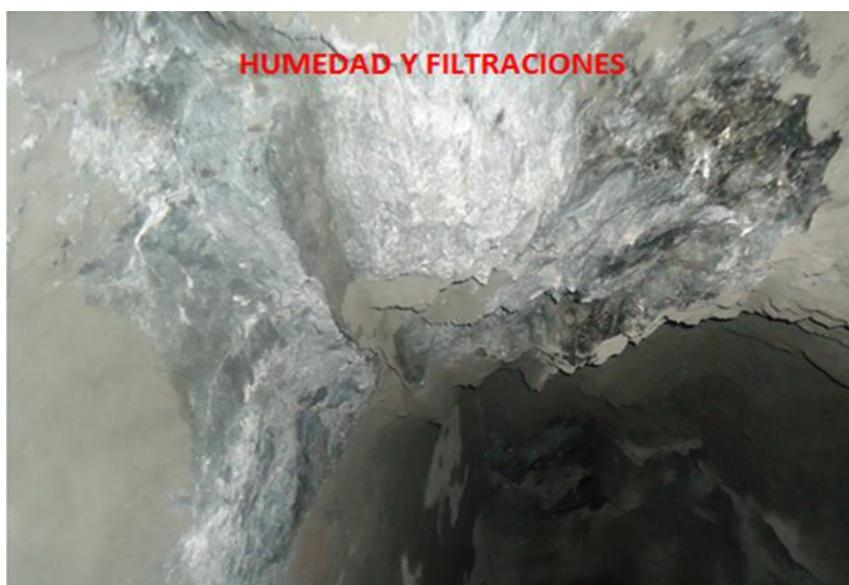
Figura N° 12: Humedad y filtraciones en la galería de producción de la veta Buenos Aires.
