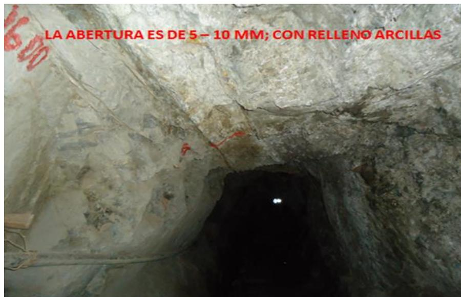
Figura N° 10: La variación de la abertura y el relleno que se encuentra relleno por arcillas, roca triturada y una alteración argílica en la bóveda central de la galería.
