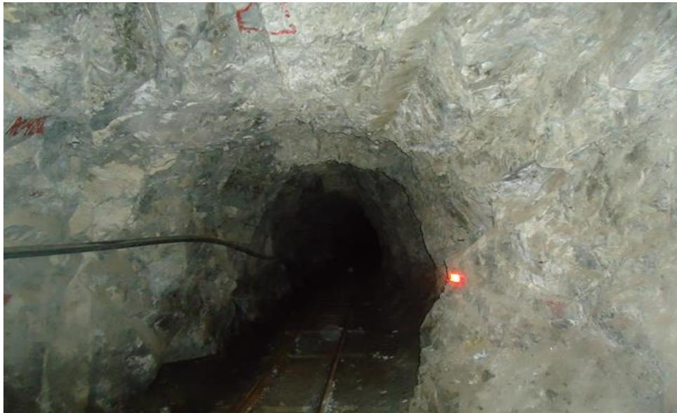
Figura N° 9: Los planos de discontinuidades; como se observa en la bóveda central de la galería de producción 090, progresiva, 680, caracterizados por granodioritas.
