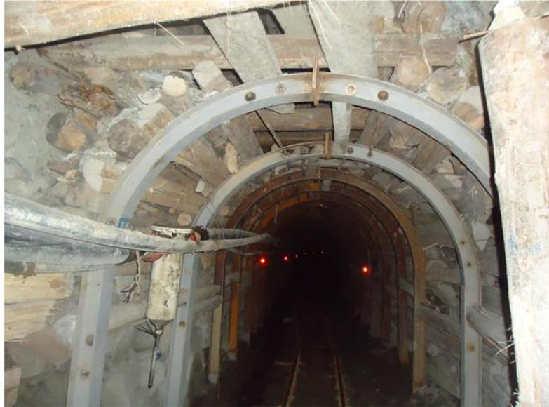
Figura Nº 3: Instalación de cimbras, con distanciamiento en cada Metro, en roca de tipo III.
