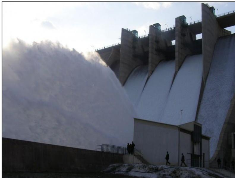
La presa de Rialb, cuyas obras de construcción terminaron en marzo de 2000, constituye una notable obra hidráulica, tanto por sus magnitudes como por los procesos y tecnología empleados en su construcción como es el Concreto Compactado con Rodillo (CCR).
