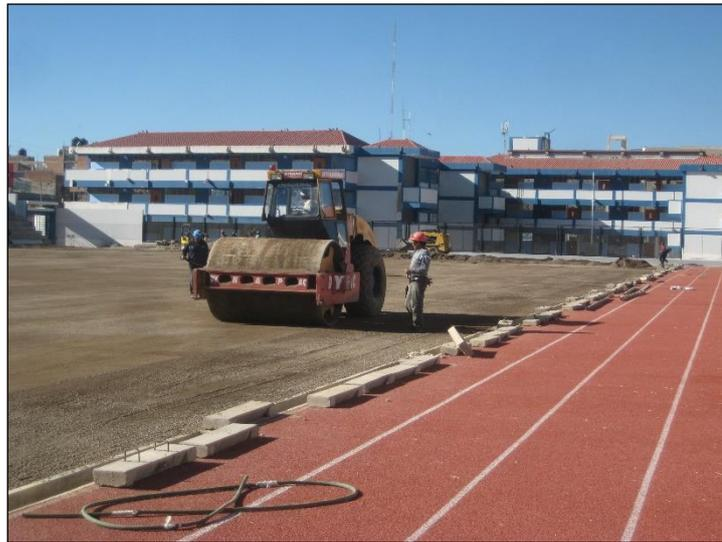
Después de que la compactación descrita haya sido terminada la superficie será refinada manualmente no permitiéndose errores de más de 10 mm en una regla de 3m. Procediéndose luego a la aplicación de la capa de acabado de 5 cm en forma manual con reglas.
