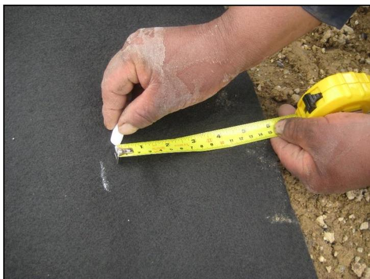
Previamente para la colocación del geotextil la superficie se deberá compactar a un 95% del proctor modificado.
