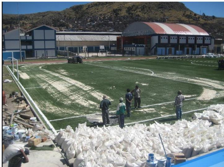
FIGURA 72: COLOCADO DE CAUCHO MOLIDO SOBRE CAMPO DEPORTIVO.
