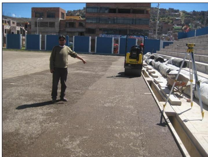
La capa de piedra base del césped sintético, está compuesta por dos partes; una capa base, de 0.19 metros en la zona inferior y una capa de acabado, de 0.05 metros, en la zona superior debiendo ser nivelada y compactada con un margen de error de no más de 10 mm en regla de 3 m, debiendo obtenerse la cota NPT + 3816.82 m.s.n.m., en toda la superficie.
