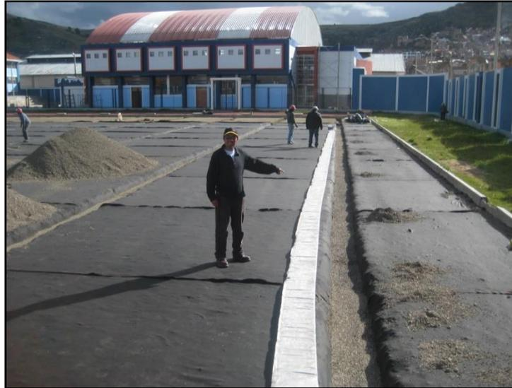
FIGURA 59: DISPOSICION DE TUBERIAS DE DRENAJE EN ZANJAS DE CAMPO DEPORTIVO
