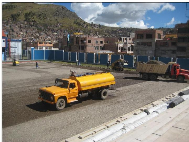
Inmediatamente después de extendido regado con óptima humedad y perfilado todo el material colocado deberá ser compactado al 95% Proctor modificado.
