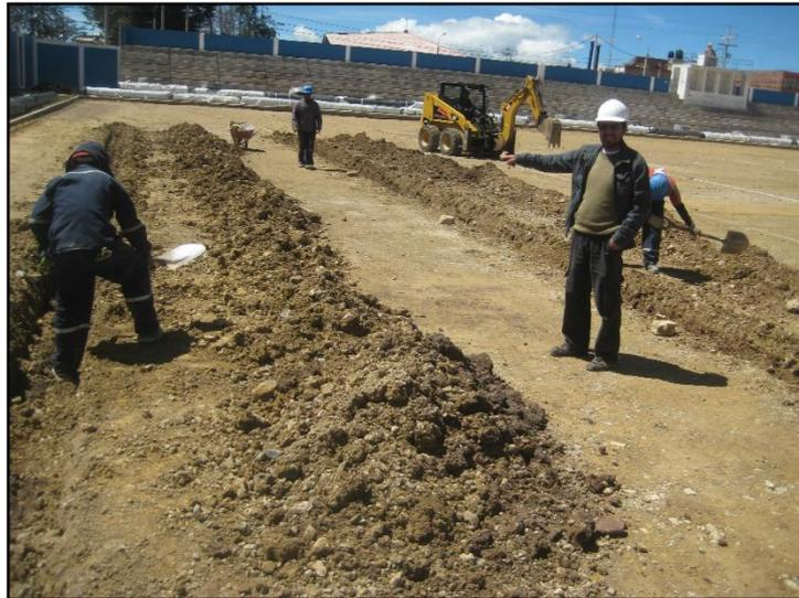
FIGURA 54: DISPOSICIÓN DE ZANJAS DE DRENAJE EN CAMPO DEPORTIVO.
