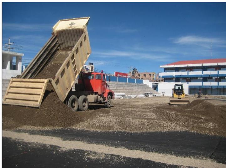
La piedra de la capa base deberá ser esparcida y será completamente mezclada por medio de una cuchilla en toda su profundidad de la capa, llevando alternadamente toda la capa hacia el centro y a las orillas de la calzada regándose el material durante la mezcla.
