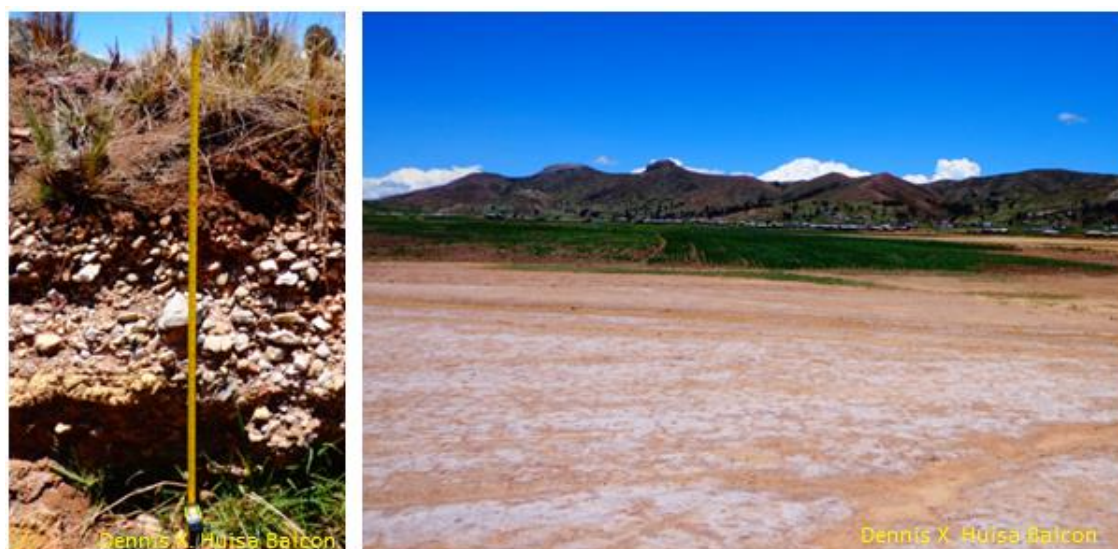
FIGURA 9. Profundidad del Canal 1m, (izquierda); interior de la zona degradada, se observa vida vegetal en los alrededores (derecha), Ahuallane, 2015-2016.
