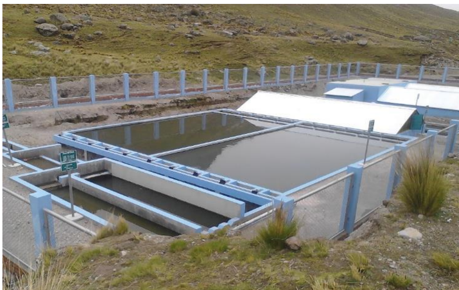
Figura 1: Planta de tratamiento de aguas residuales del distrito de Vilavila.
