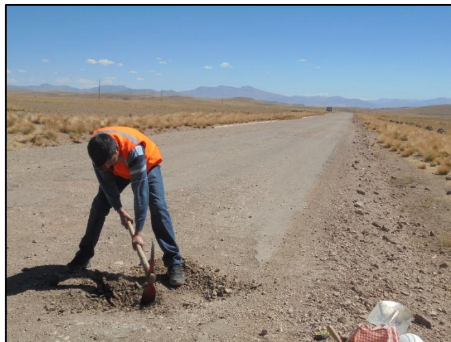
Fotografía N° 31. Excavación de calicata para muestreo de la capa base.
