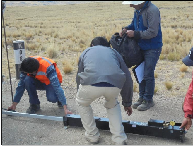
Fotografía N° 23. Ensayo viga benkelman km 06+000. Primer tramo crítico.
