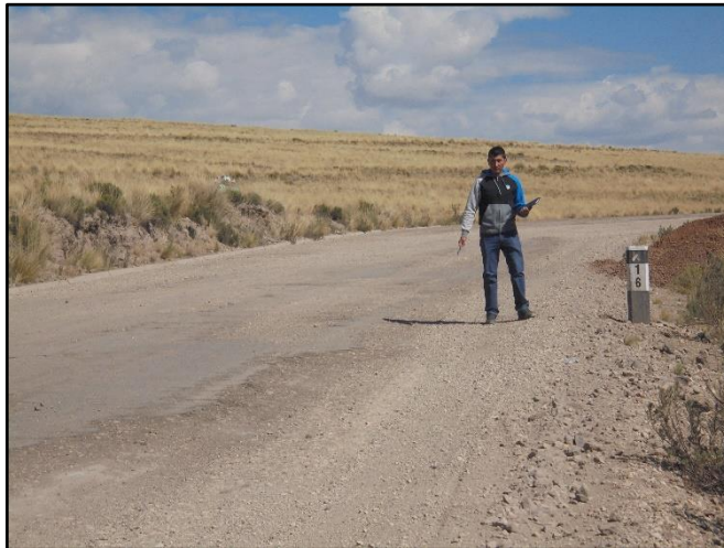
Fotografía N° 2. Vía Puno – Vilque – Mañazo progresiva: km 16+000 segundo tramo crítico.
