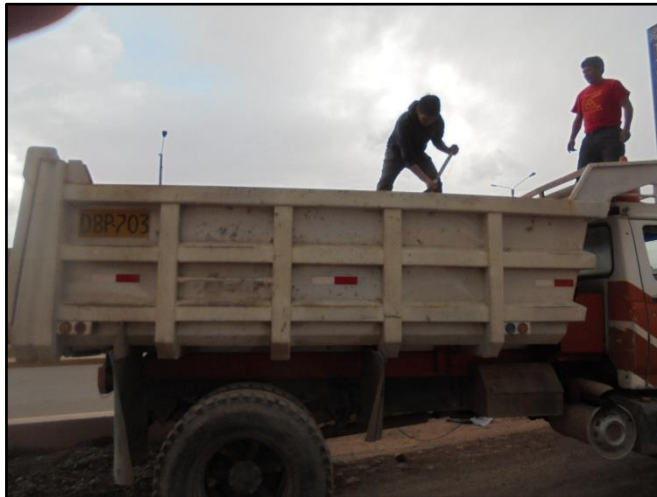
Fotografía N° 13. Nivelando la parte superior de la grava para distribuir la carga uniformemente.
