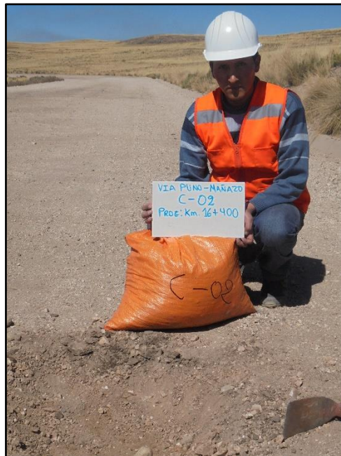
Fotografía N° 33. Calicata C2 – segundo tramo crítico.
