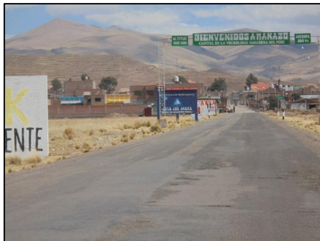
Fotografía N° 11. Distrito de Mañazo km 39+900.
