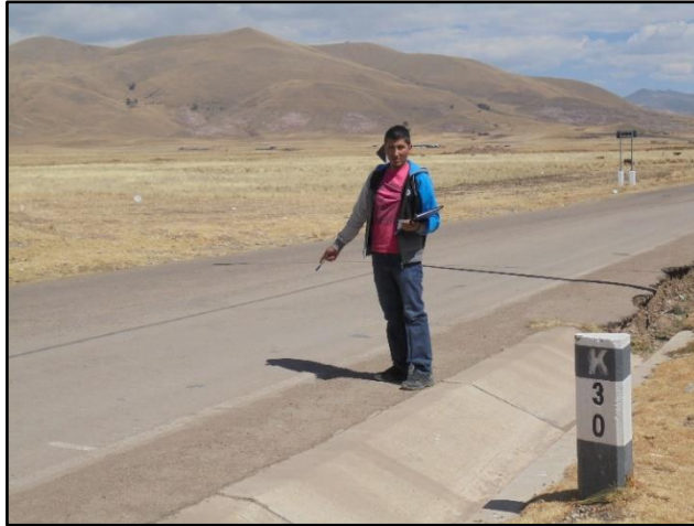
Fotografía N° 9. Km 30+000 que resultado tener un PCI= 43 y condición "regular".
