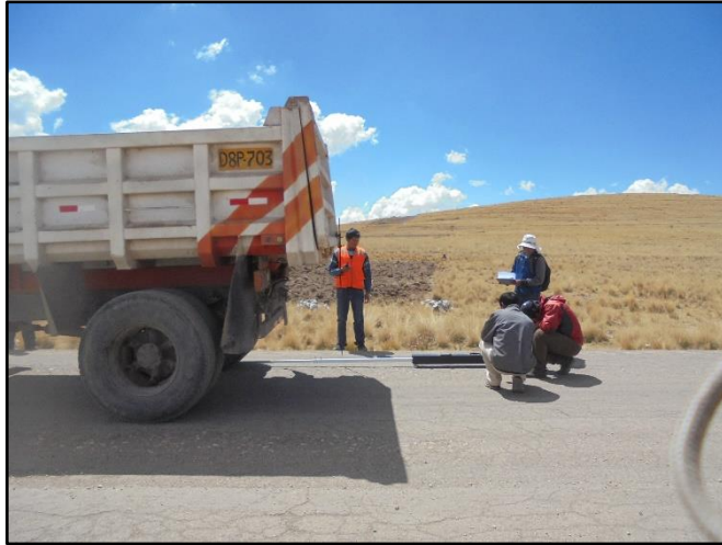
Fotografía N° 20. Señal de inicio para que avance el camión C2. Posición L0 - Deflexión máxima D0.
