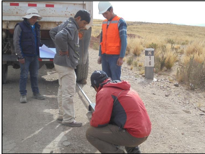
Fotografía N° 24. Ensayo deflectométrico progresiva 16+000 segundo tramo crítico.
