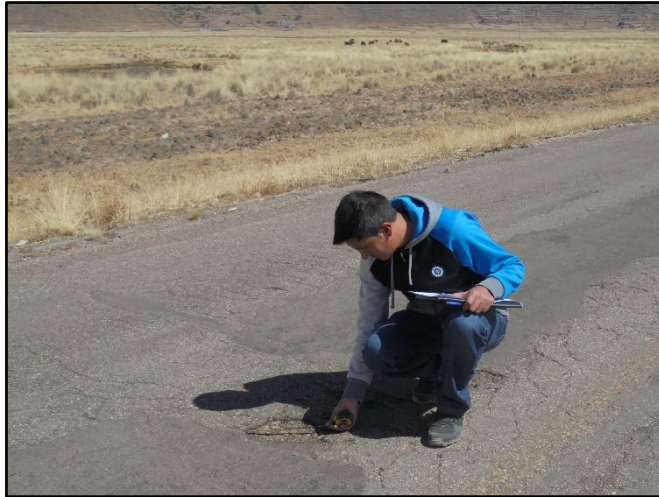
Fotografía N° 5. Falla 13 huecos con nivel de severidad bajo.
