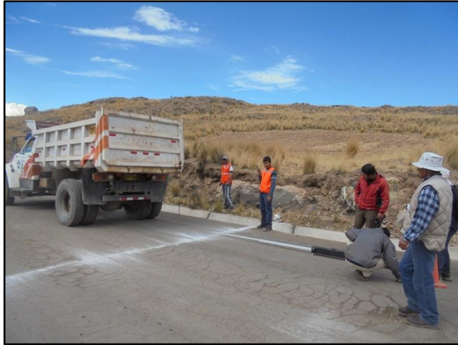
Fotografía N° 17. Marcado con yeso perpendicular a la vía cada 50m.
