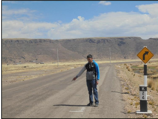
Fotografía N° 7. Vía Puno - Vilque – Mañazo: km 24+000.
