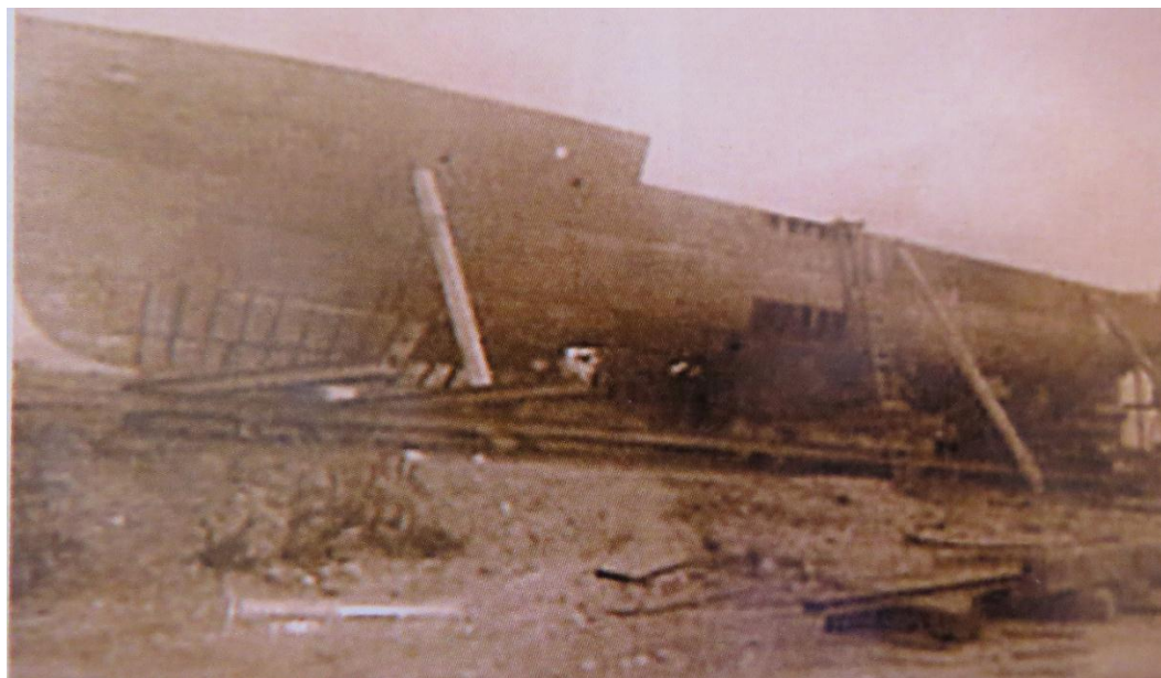
IMAGEN N° 19: Armado de la cañonera Yavarí en el Astillero de Huaje. FUENTE: Juan Barriga Aranibar. 1870.
