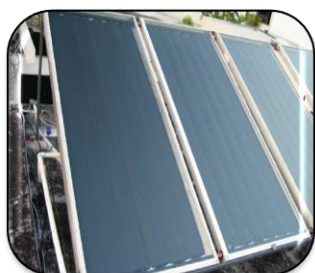
Figura 5.13: Captador solar de aire con placas paralelas y aletas rectangulares.
