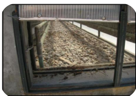
Figura 5.21: Lecho de piedra como acumulador de calor para el secadero de tomates. Fuente: INCIHUSA – CONICET. Universidad de Mendoza. 2009.
