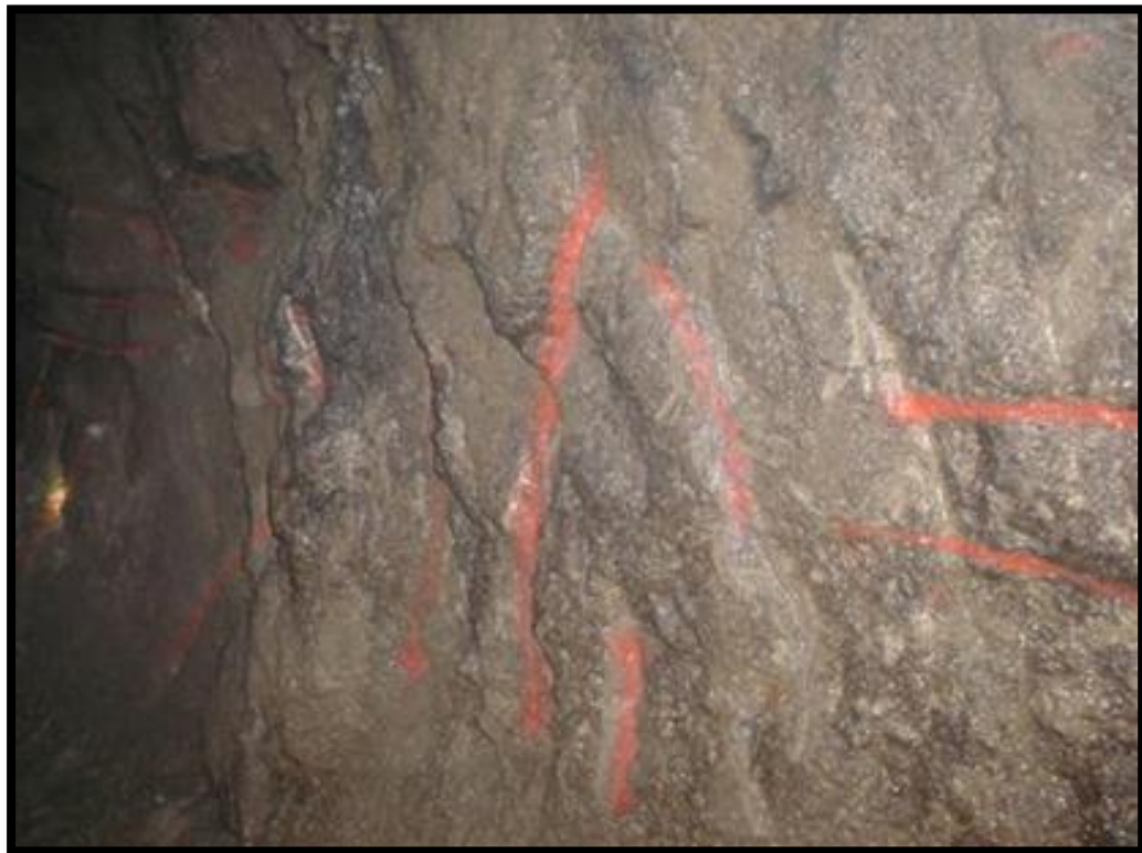
Fig. 3.7. Observación de las discontinuidades
