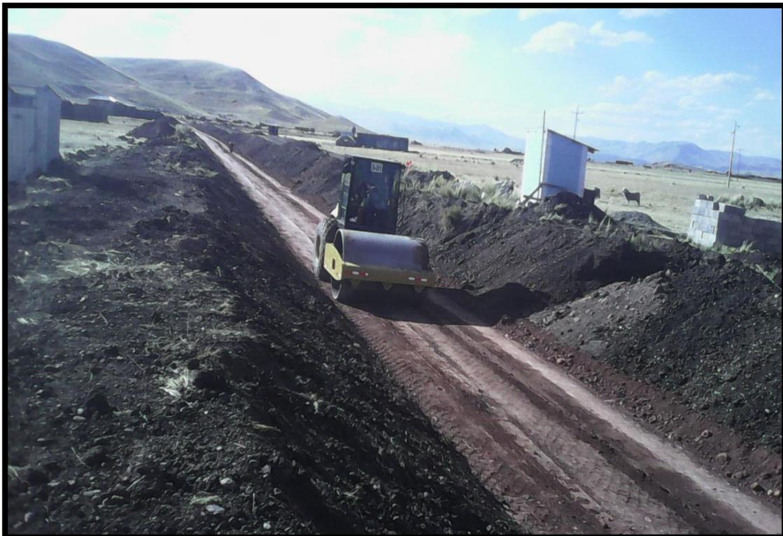
**FOTOGRAFÍA 06:** Se realiza trabajos de conformación de terraplen
