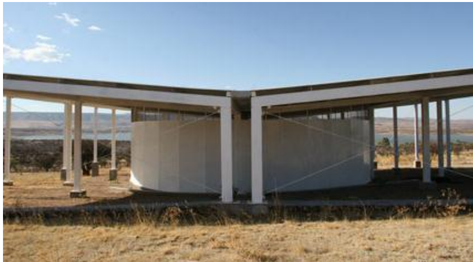
Figura 1: TECHO DE CUENCA
