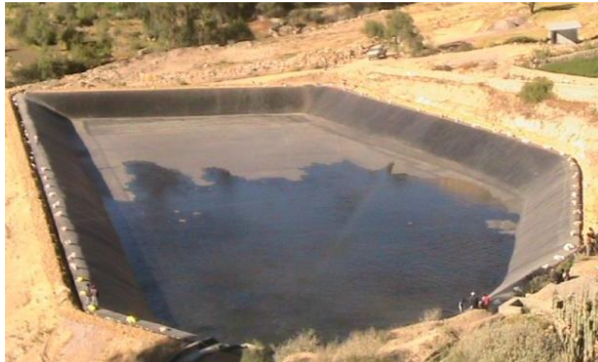
Figura 2: CAPTACION EN GEOMENBRANA Fuente: (Guzman, 2014).
