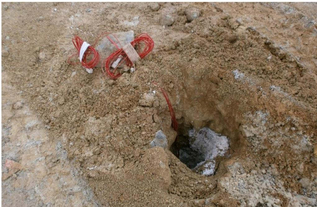
**Foto 4.** Perforación de un taladro por el carguío con explosivo.
