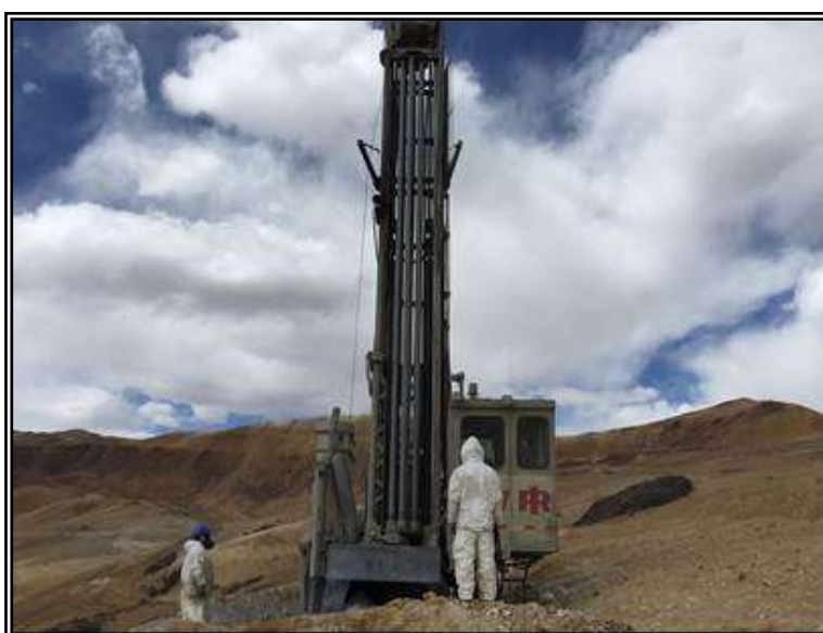
Figura 42: Equipo de perforación DM45E.
