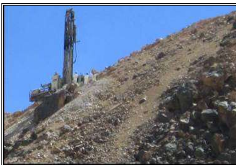
Figura 41: Perforación de Infill Drilling, en zona de morrena.
