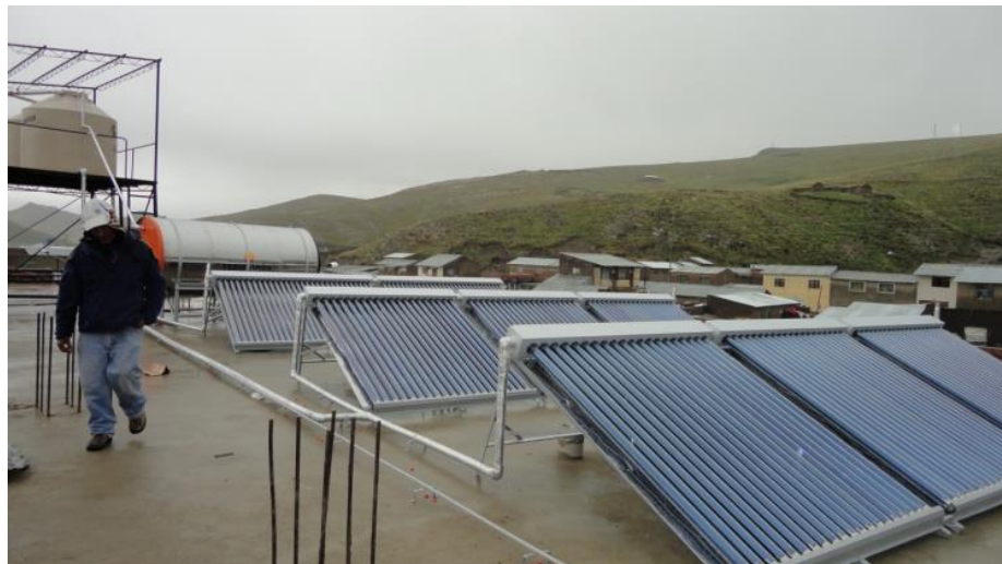
Figura 54: Instalación del sistema de calentamiento solar en la región de Puno Fuente: Cotización del sistema de calentamiento solar (Anexo 09)
