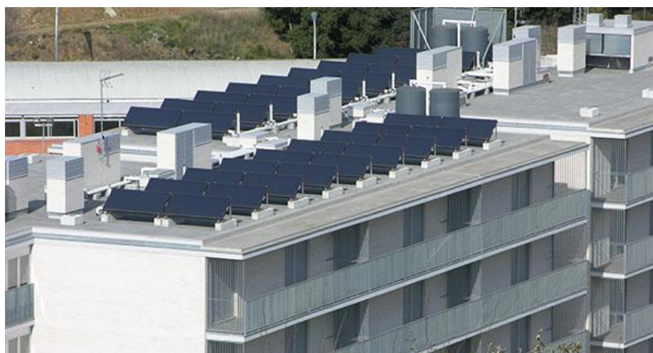
Figura 55: Ejemplo de instalación del sistema de calentamiento solar en hoteles Fuente: Cotización del sistema de calentamiento solar (Anexo 09)
