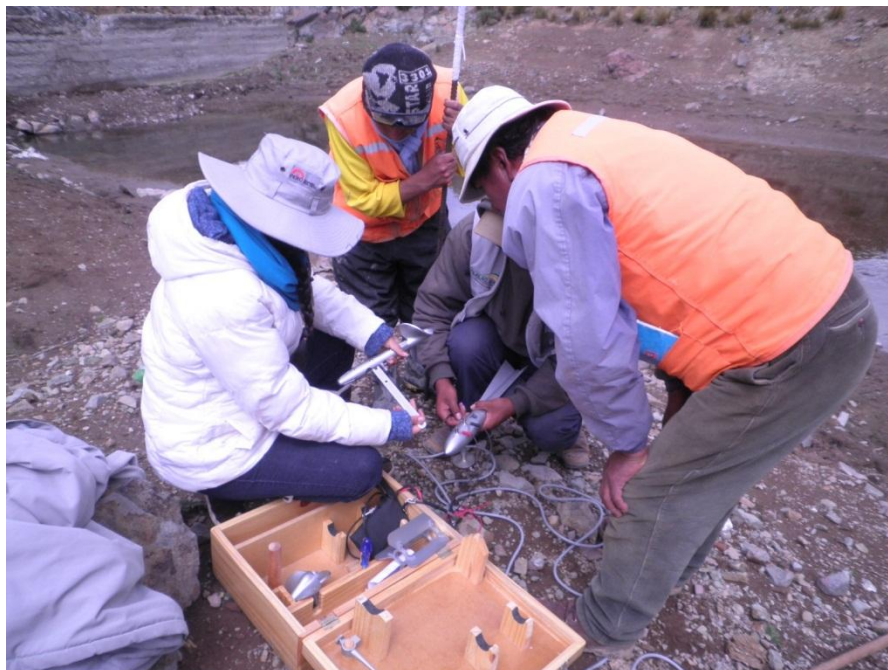
Fotografía 8. Instalando el correntómetro para el aforo
