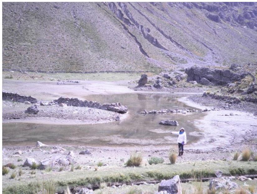
Fotografía 6. Reconocimiento del lugar de la mini presa de Cachipascana.
