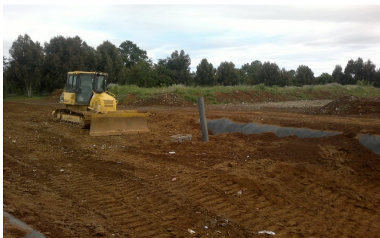
FIGURA 3 RELLENO SANITARIO EN SUPERFICIE
