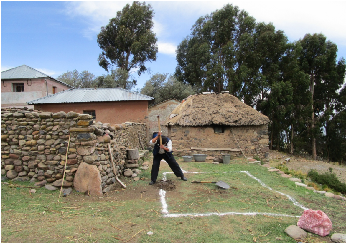
REALIZANDO LA EXCAVACION PARA EL ALMACENAMIENTO DEL AGUA DE LLUVIA
