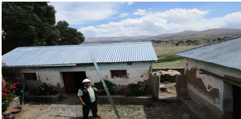
Figura Nº 14: Vivienda con techo de calamina galvanizada - 2015. Fuente: Elaboración propia
