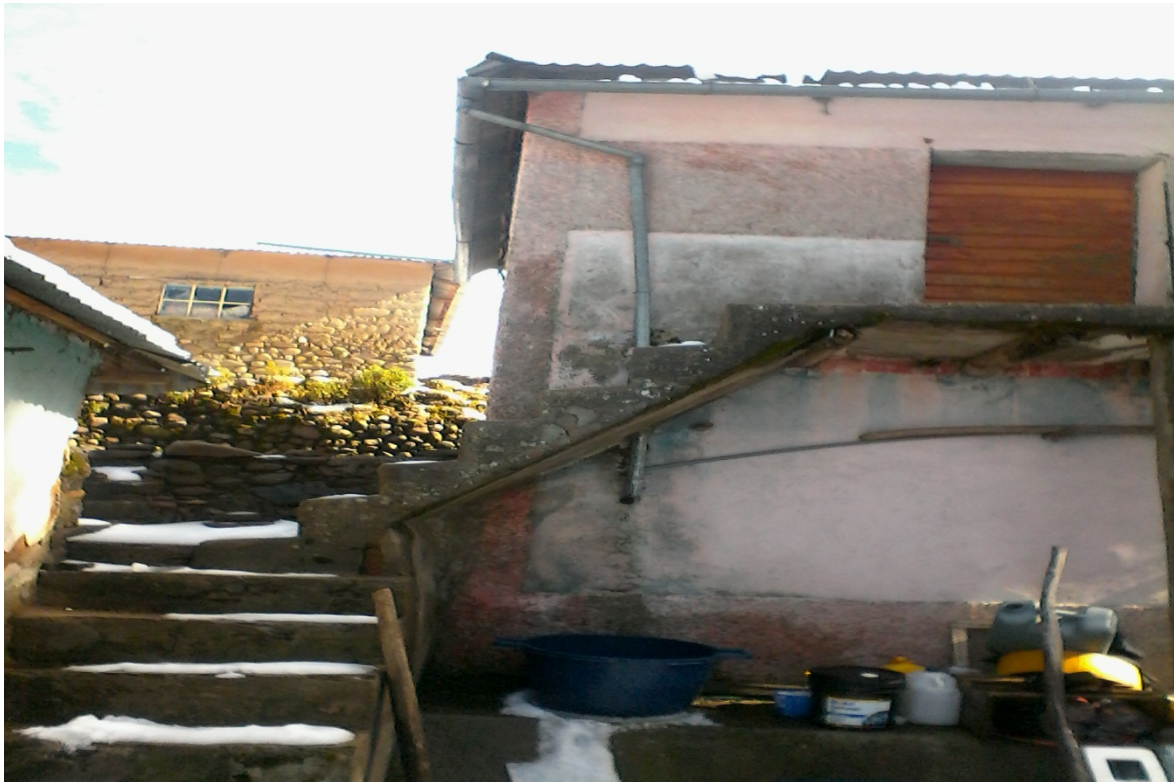
Figura N° 01: Sistema de captación de agua de lluvia en techos Fuente: Elaboración propia.
