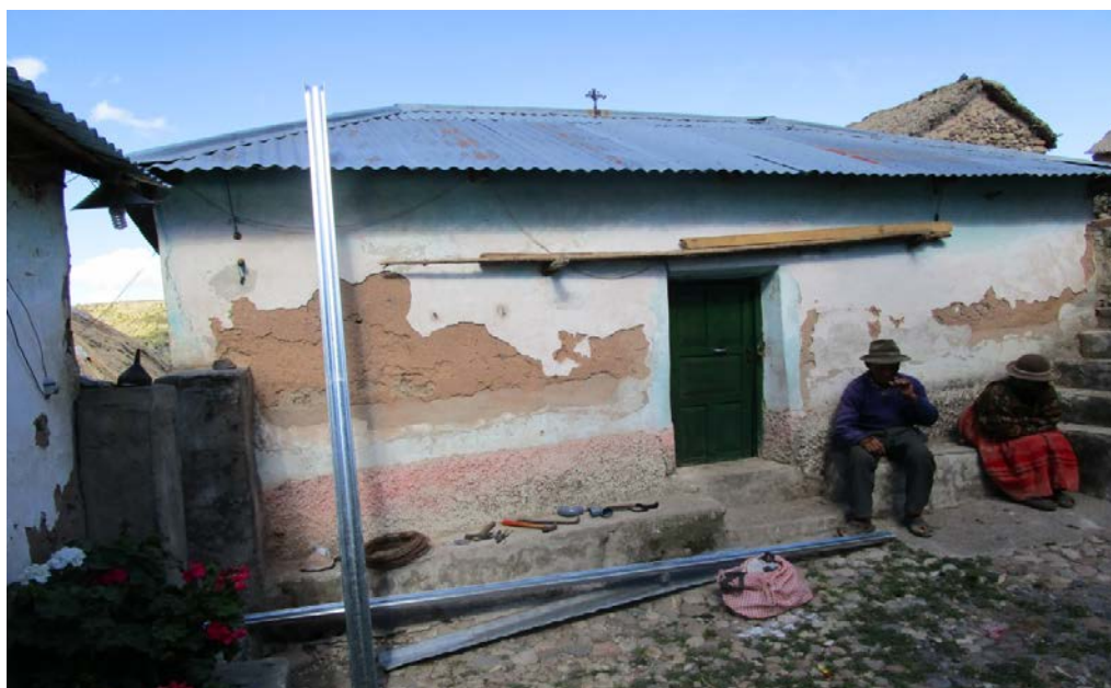
Figura N° 12: Vivienda sin canaleta para la colección del agua de lluvia – 2015. Fuente: Elaboración Propio
