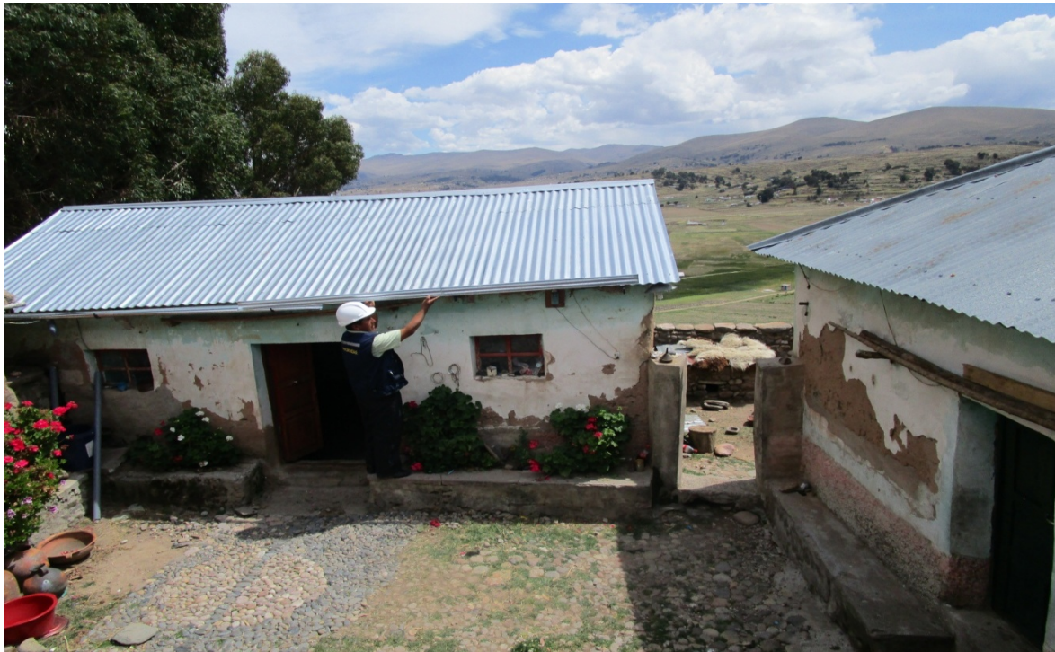
INSTALANDO LAS CANALETAS DE MATERIAL LAMINA GALVANIZADA
