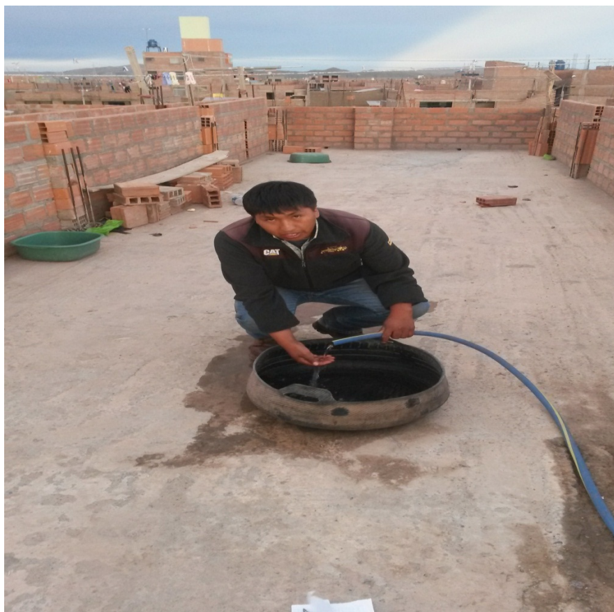
Agua Bombeada con el Ariete Hidráulico de 2" a 7m
