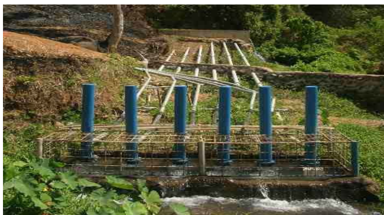
Figura 14: Instalación de 6 bombas de ariete conectadas en paralelo.
