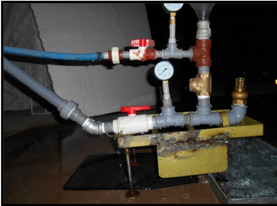
Fotografías 20: Se aprecia en funcionamiento la bomba de ariete hidráulico
