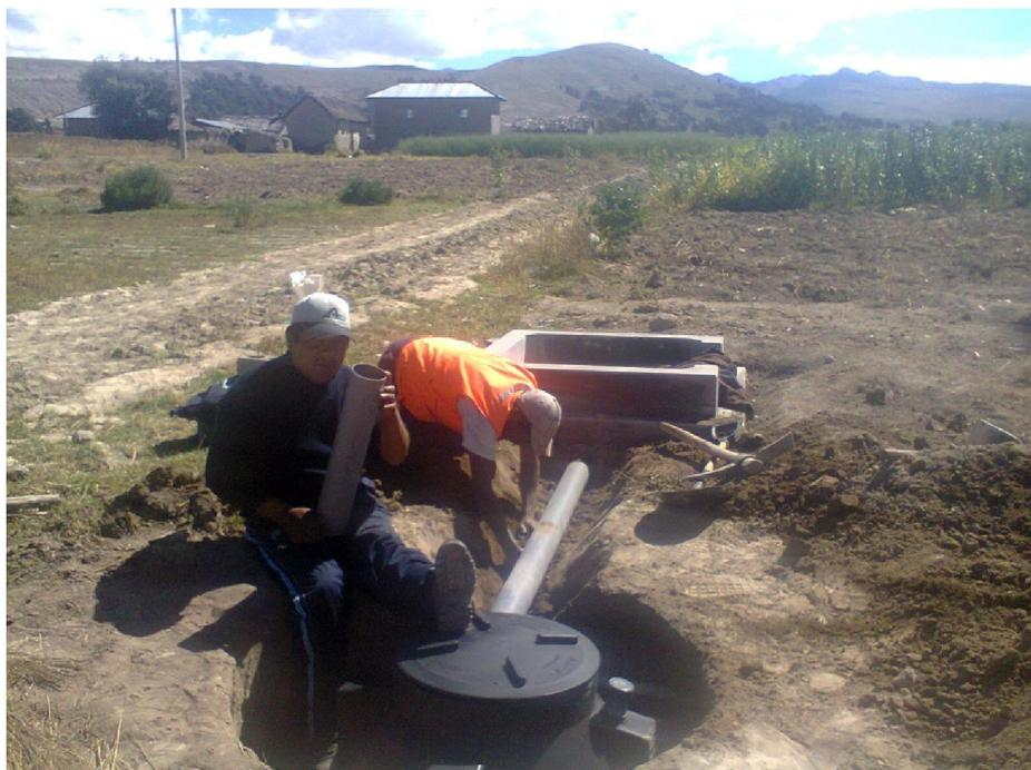
**Imagen 16: Instalación del biodigestor autolimpiable**
