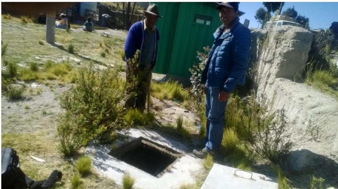
**Imagen 10: Pozo percolador abierto para muestreo del efluente**
