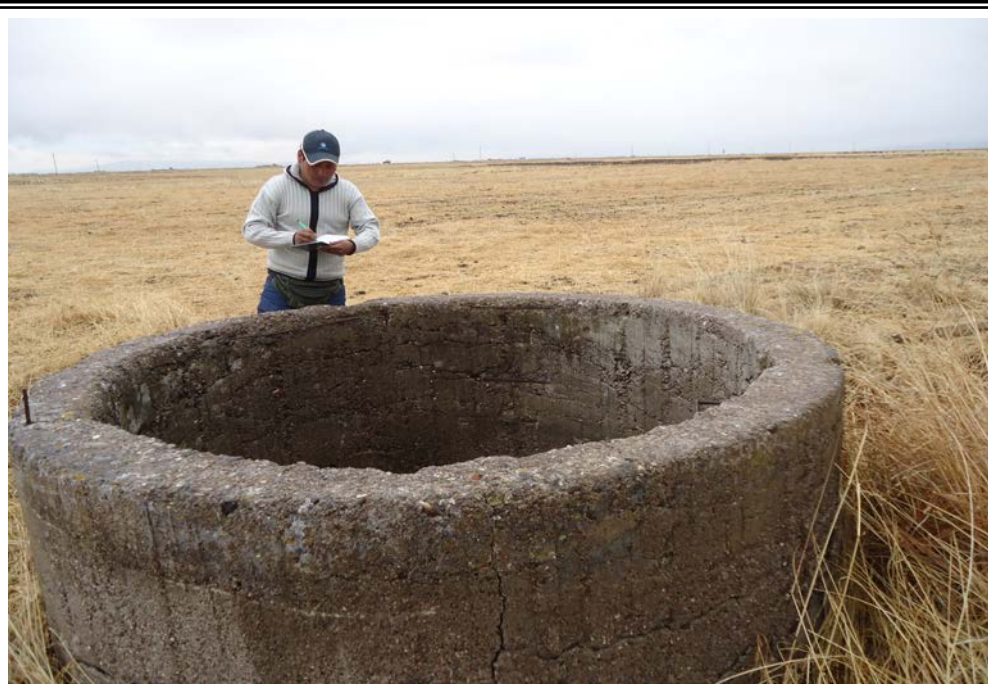
PROYECTO DE TESIS: Evaluación de aguas subterráneas con fines de riego presurizado en C. E. INIA
