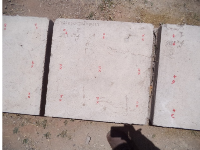
Gráfico 4.12: Losa de concreto protegido con estiércol de corral.
