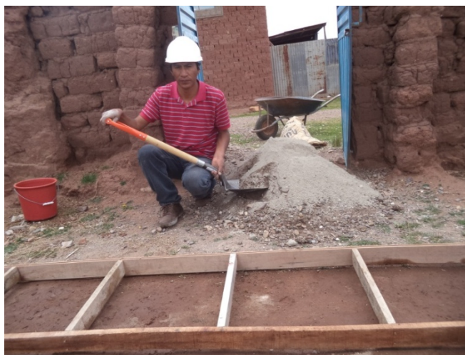
Gráfico 4.14: Preparado de encofrados y mezcla de concreto para las losas.
