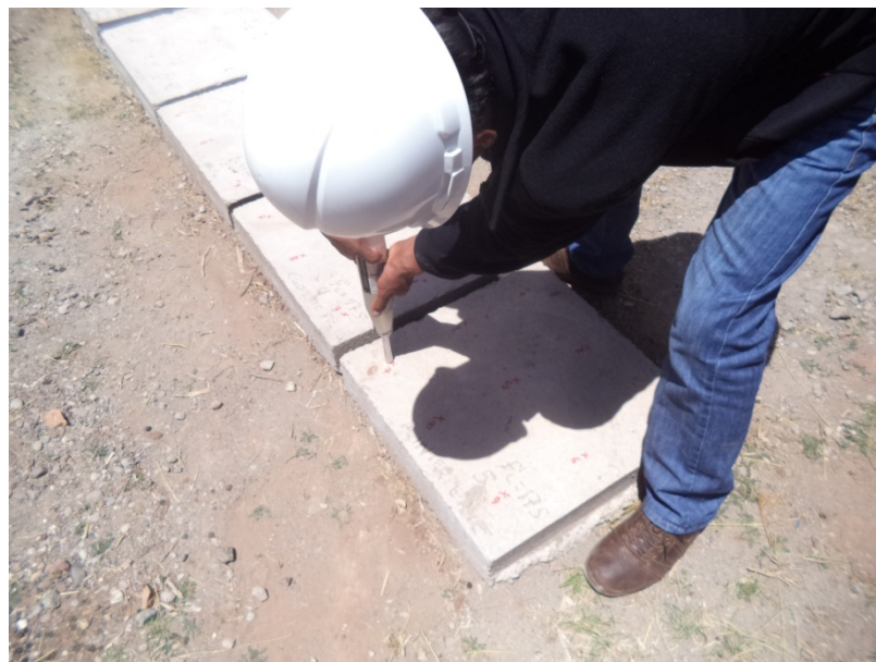
Gráfico 4.17: Prueba de medición de las losas de concreto con equipo de esclerómetro en cada losa pero en sus 9 diferentes puntos.
