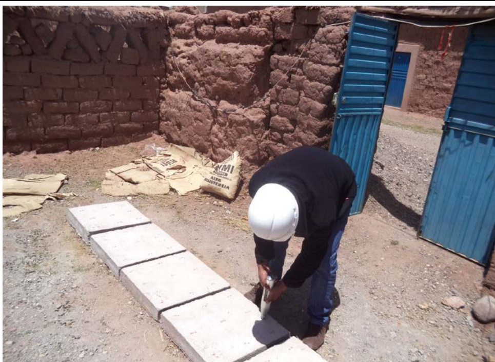
VISTA 09: EN LA VISTA SE MUESTRA REALIZANDO LOS DISPAROS A LAS LOSAS CON SCLEROMETRO.
