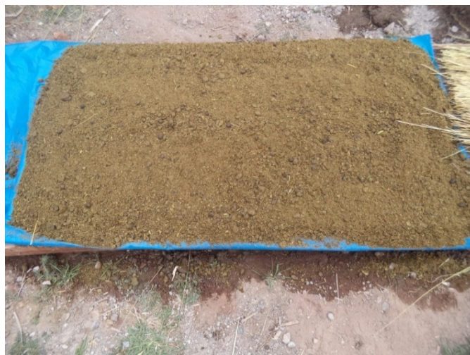
Gráfico 4.10: Curado de concreto fresco con estiércol de corral.
