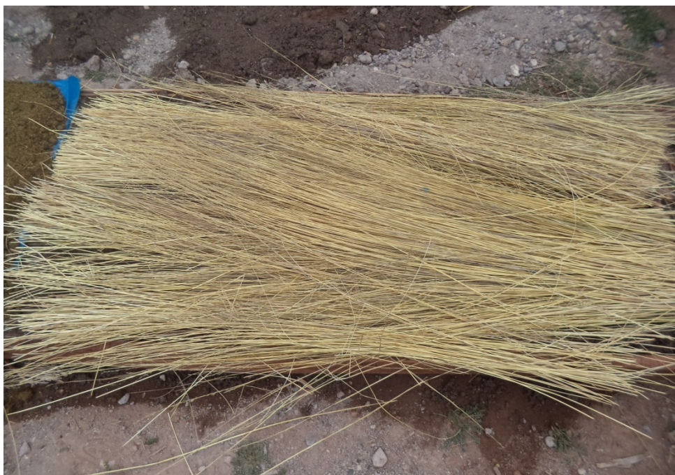
VISTA 06: EN LA VISTA SE MUESTRA EL COLOCADO DE COBERTURAS DE CONCRETO FRESCO CON PLASTICO Y PAJA.
