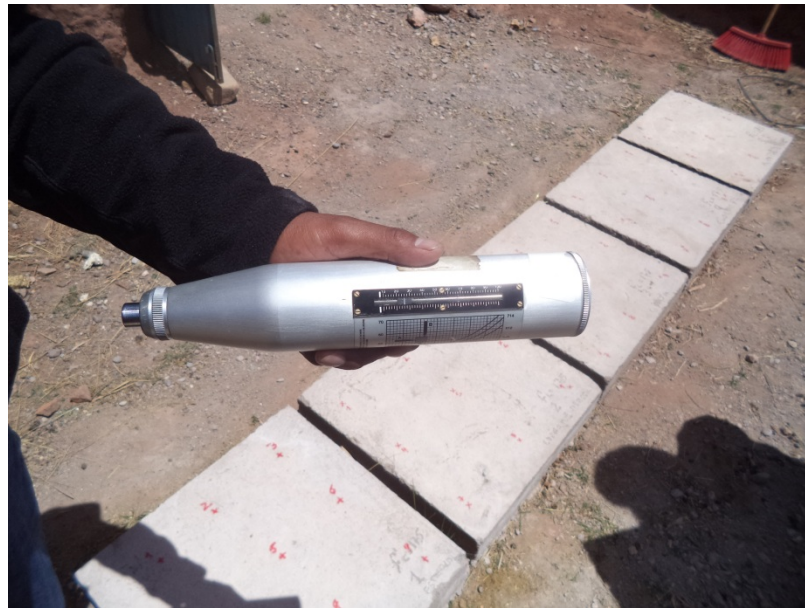
Gráfico 4.16: Prueba de medición de las losas de concreto con equipo de esclerómetro.
