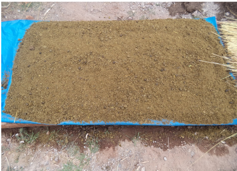
VISTA 05: EN LA VISTA SE MUESTRA EL COLOCADO DE COBERTURAS DE CONCRETO FRESCO CON PLASTICO Y GUANO.
