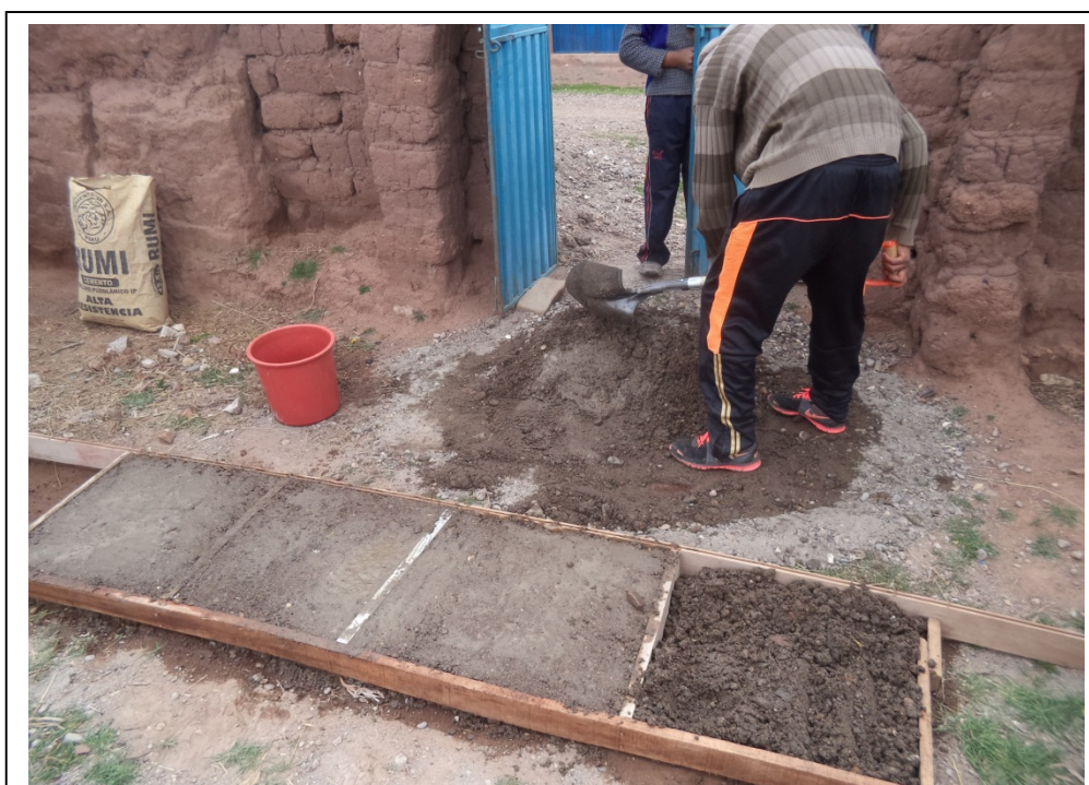
VISTA 02: EN LA VISTA SE MUESTRA EL COLOCADO DE MEZCLA DE CONCRETO.
