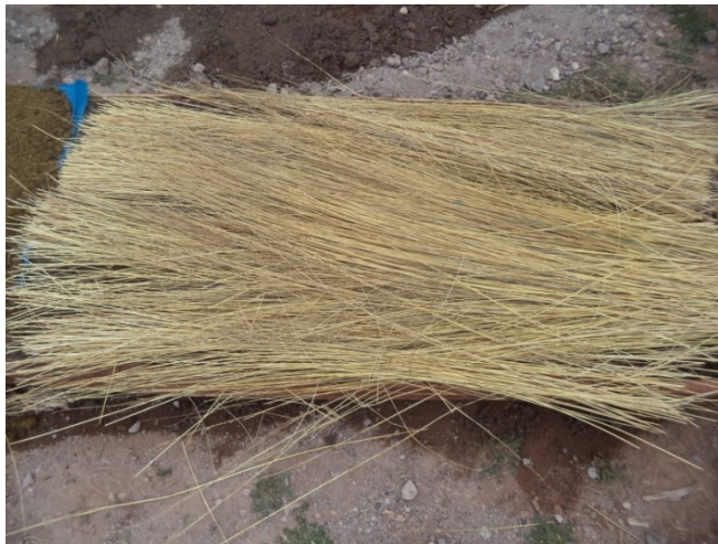
Gráfico 4.11: Curado de concreto fresco con paja del altiplano.
