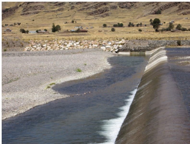
Foto N° 04: VISUALIZA EL BARRAJE FIJO Y EL ENCAUZAMIENTO CON ROQUERIO PARA CANALIZAR EL AGUA.
