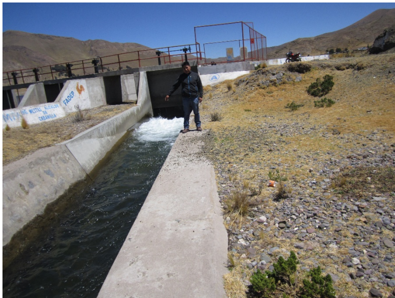
Foto N° 02: SE VERIFICA Y OBSERVA EL FUNCIONAMIENTO Y OPERACIÓN DEL CANAL PRINCIPAL
