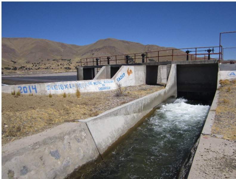
Foto N° 01: SE VERIFICA Y OBSERVA EL FUNCIONAMIENTO DE LA BOCATOMA
