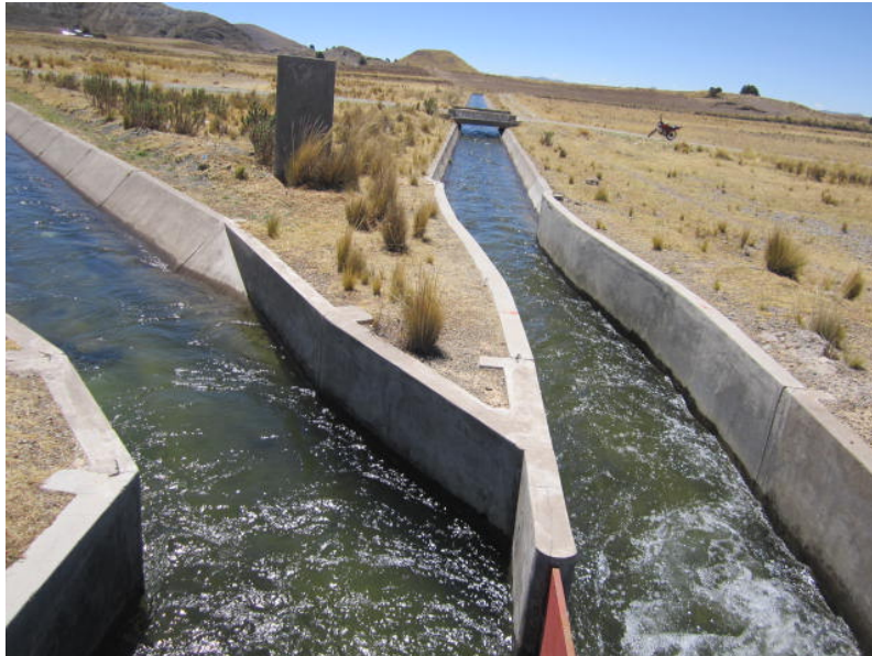
Foto N° 10: SE VERIFICA Y OBSERVA EL FUNCIONAMIENTO DEL PARTIDOR METÁLICO
