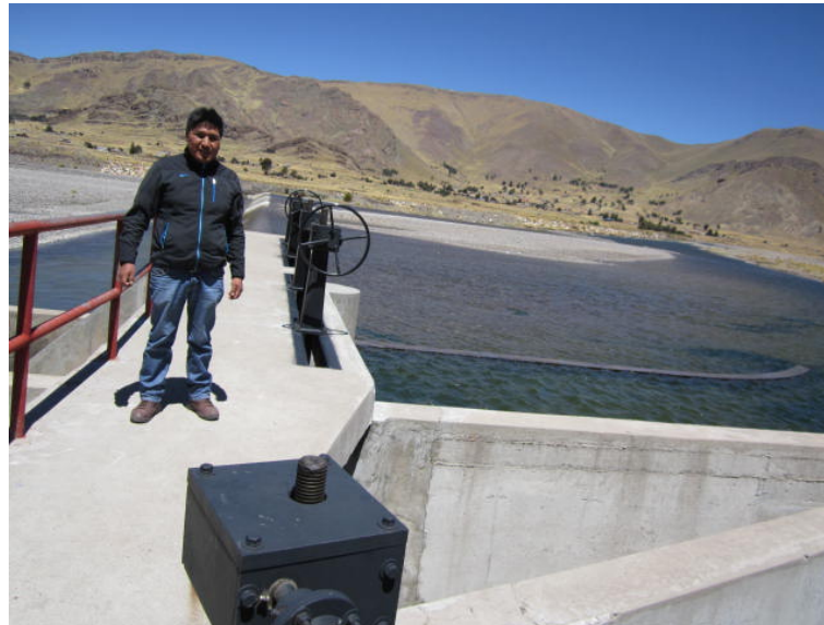
Foto N° 03: VISUALIZA LA OPERATIVIDAD DE LA BOCATOMA (COMPUERTAS METÁLICAS)
