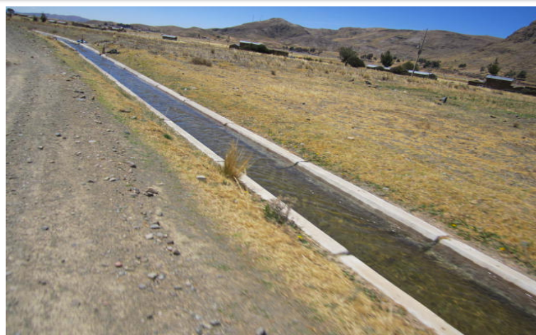
Foto N° 06: SE VERIFICA Y OBSERVA EL FUNCIONAMIENTO DEL CANAL LATERAL Y COMPUERTA PARA PARCELA (PREDIO)
