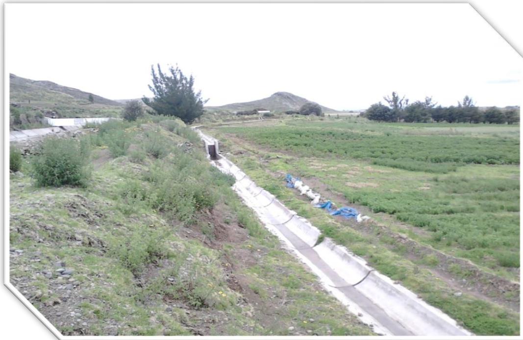
CANAL SUB LATERAL DE LA IRRIGACIÓN CABANILLA.
