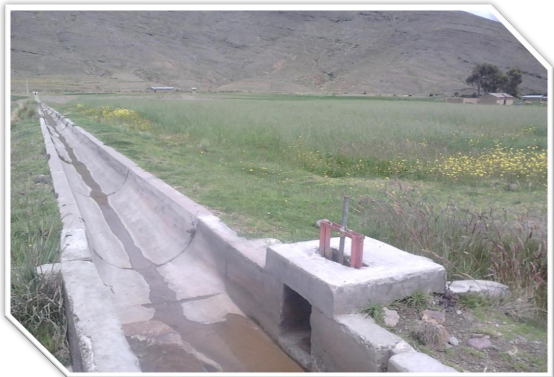
CANAL LATERAL, COMPUERTA LATERAL Y CULTIVO DE AVENA BAJO RIEGO.
