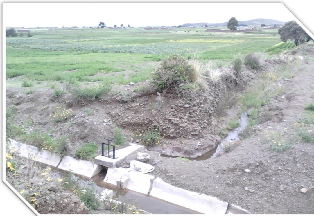
COMPUERTA SUB LATERAL Y CANAL ARTESANAL.
