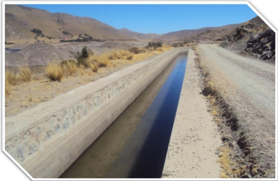
CANAL PRINCIPAL DE LA IRRIGACIÓN CABANILLA.
