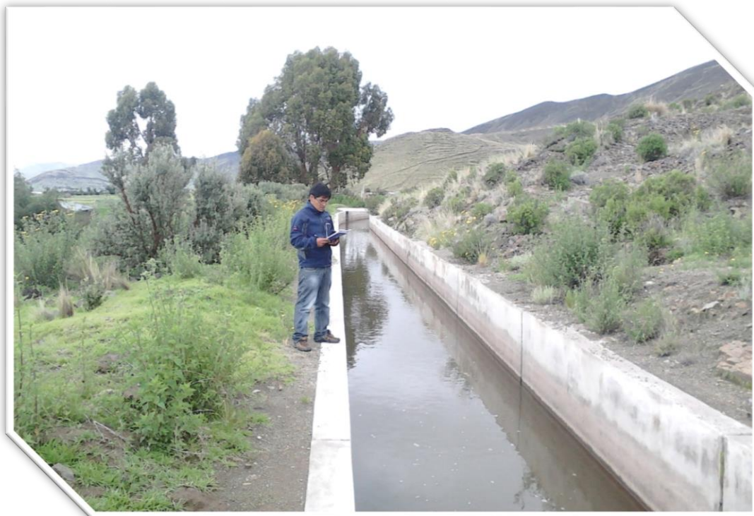
CANAL RECTANGULAR PRINCIPAL DE LA IRRIGACION CABANILLA.
