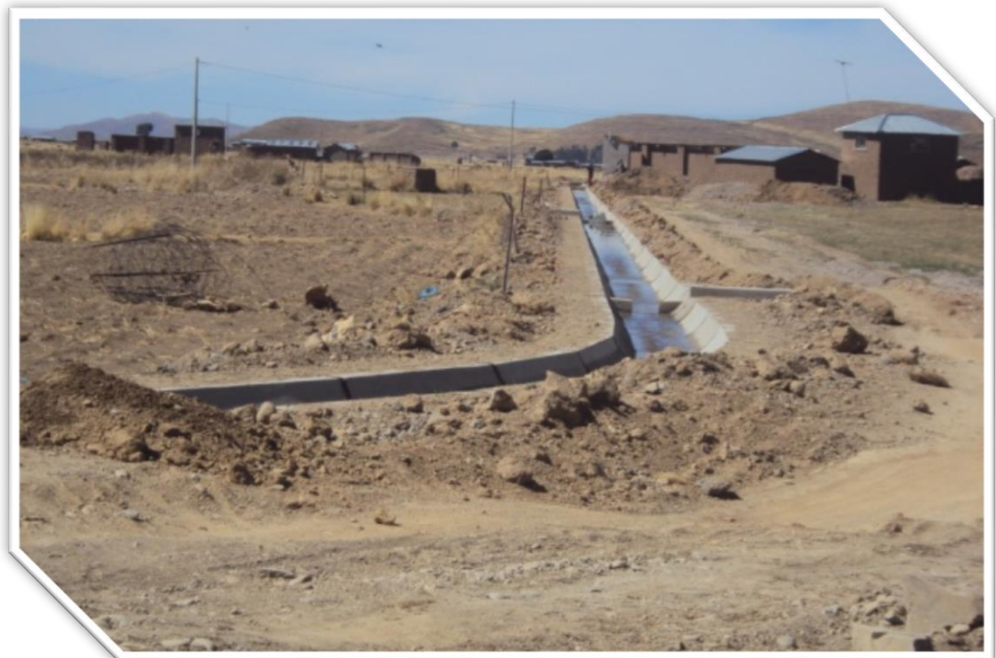
CANAL SUB LATERAL DE LA IRRIGACION CABANILLA.
