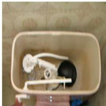
Tanque después de la descarga, con la boya inclinada, lo que permite el ingreso del agua.
