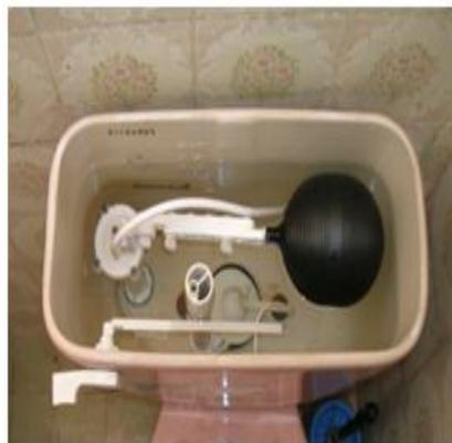
Tanque lleno de agua. La boya horizontal cierra el paso del agua.
