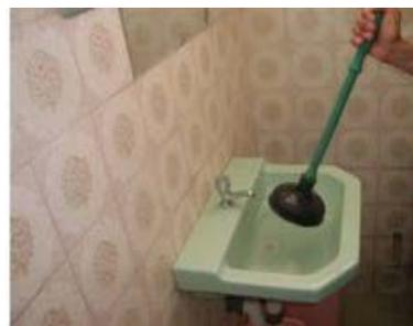
Si el chupón (bombín) o el producto químico no surte efecto, se utiliza la guaya flexible con el procedimiento empleado para desatorar tuberías; también
