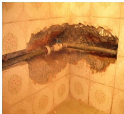
La tubería se obstruye debido al ingreso de sólidos, por el mal uso de los aparatos e instalaciones sanitarias. Para movilizar los sólidos en la tubería y permitir el paso de las aguas residuales, se utiliza una guaya. El operador mete la guaya por un extremo de la tubería hasta encontrar la obstrucción, luego la gira en sentido horario y tira hacia afuera, repitiendo el procedimiento hasta que destapone el tubo, para permitir el paso de las aguas residuales.
