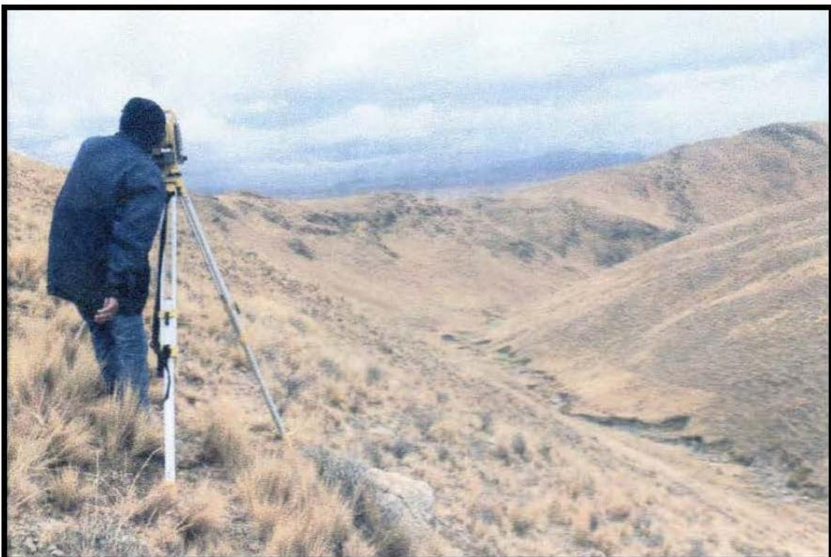
**En la imagen se observa el equipo instalado para el levantamiento de la línea de conducción**
