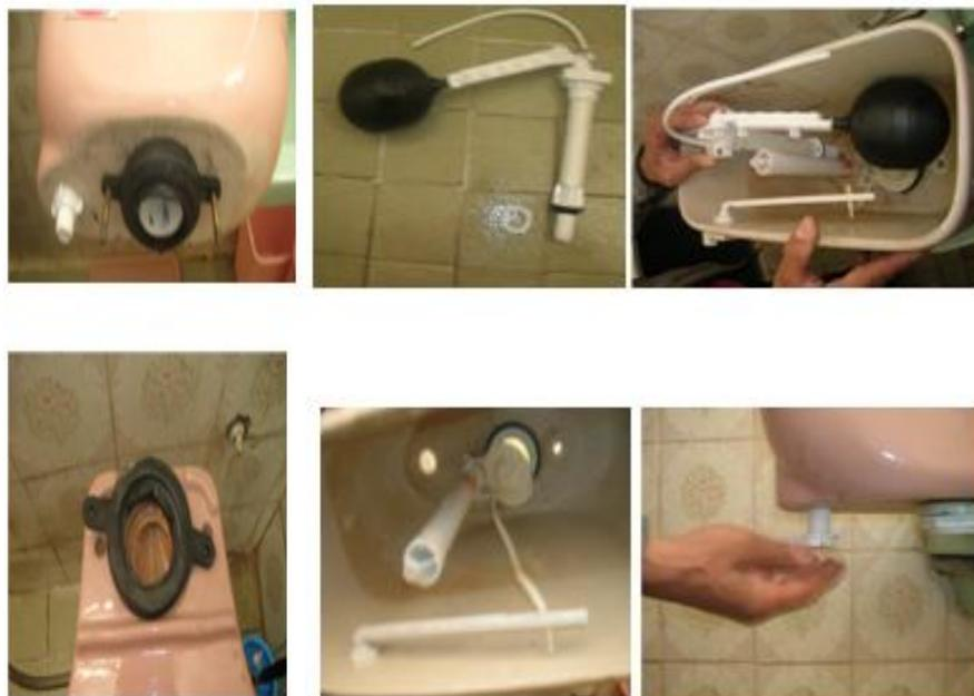
Ocasionalmente la válvula de descarga no cierra porque el tapón no sella la salida del flujo de agua. Para solucionar el desperfecto es preciso revisar el estado del tapón y sustituirlo según el caso. Si es de plástico con empaquetadura de caucho es mejor cambiarlo. Si la válvula es de bronce se revisan las guías para ver si están desalineadas, y se acomodan.
