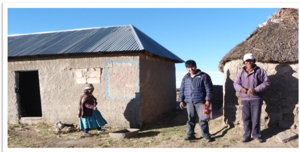
Figura 11: Vivienda sin canaleta para la colección del agua de lluvia – 2013. Fuente: Elaboración Propio
