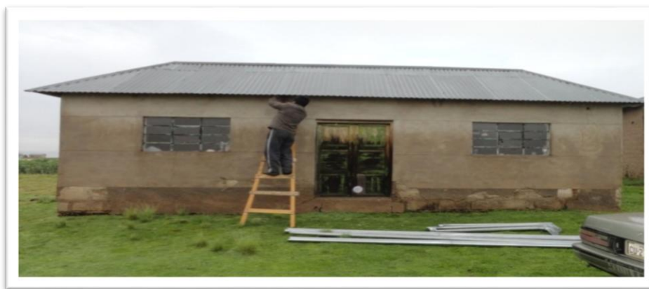
Figura 13: Vivienda con techo de calamina galvanizada - 2013. Fuente: Elaboración propia
