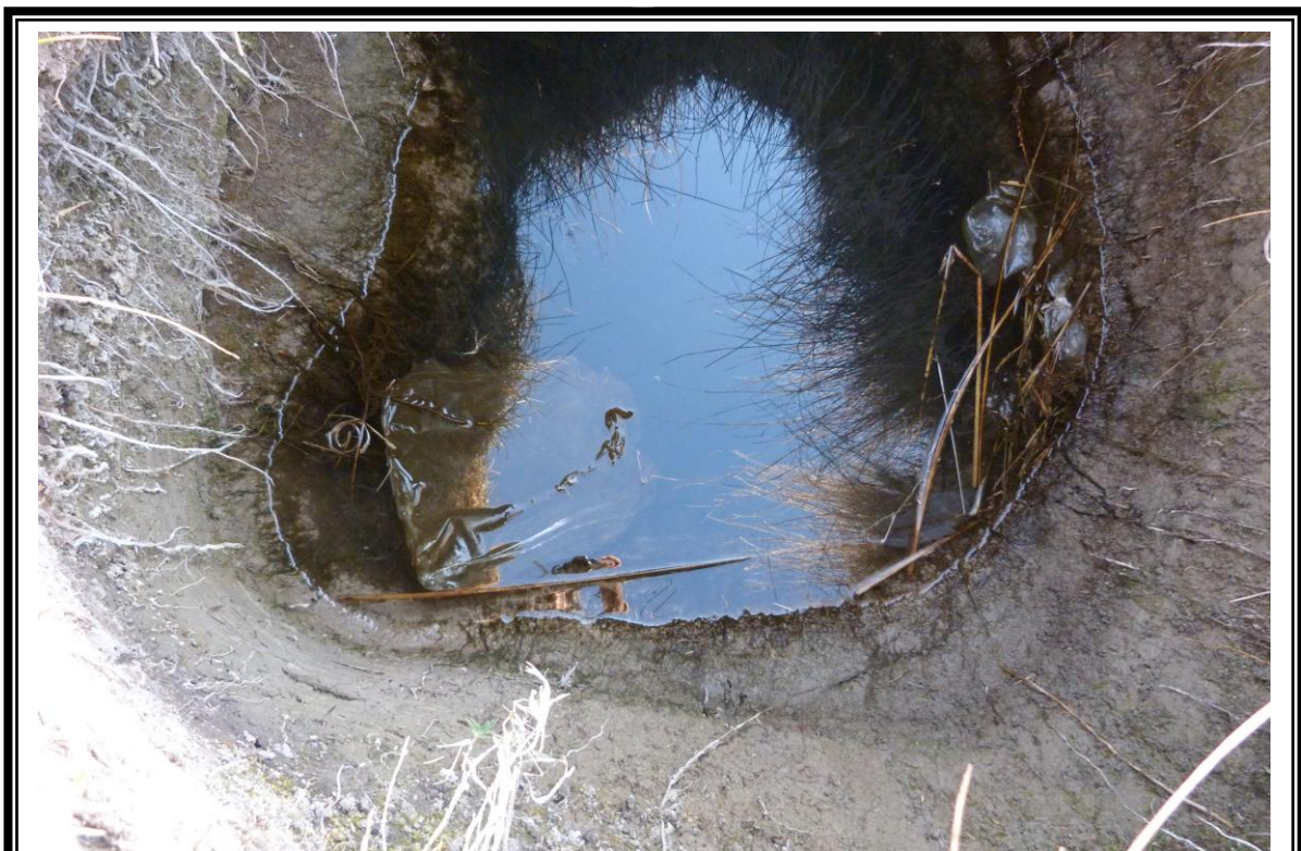
POZO RÚSTICO FUENTE DE DOTACIÓN DE AGUA DE LA POBLACIÓN EN ESTUDIO.
