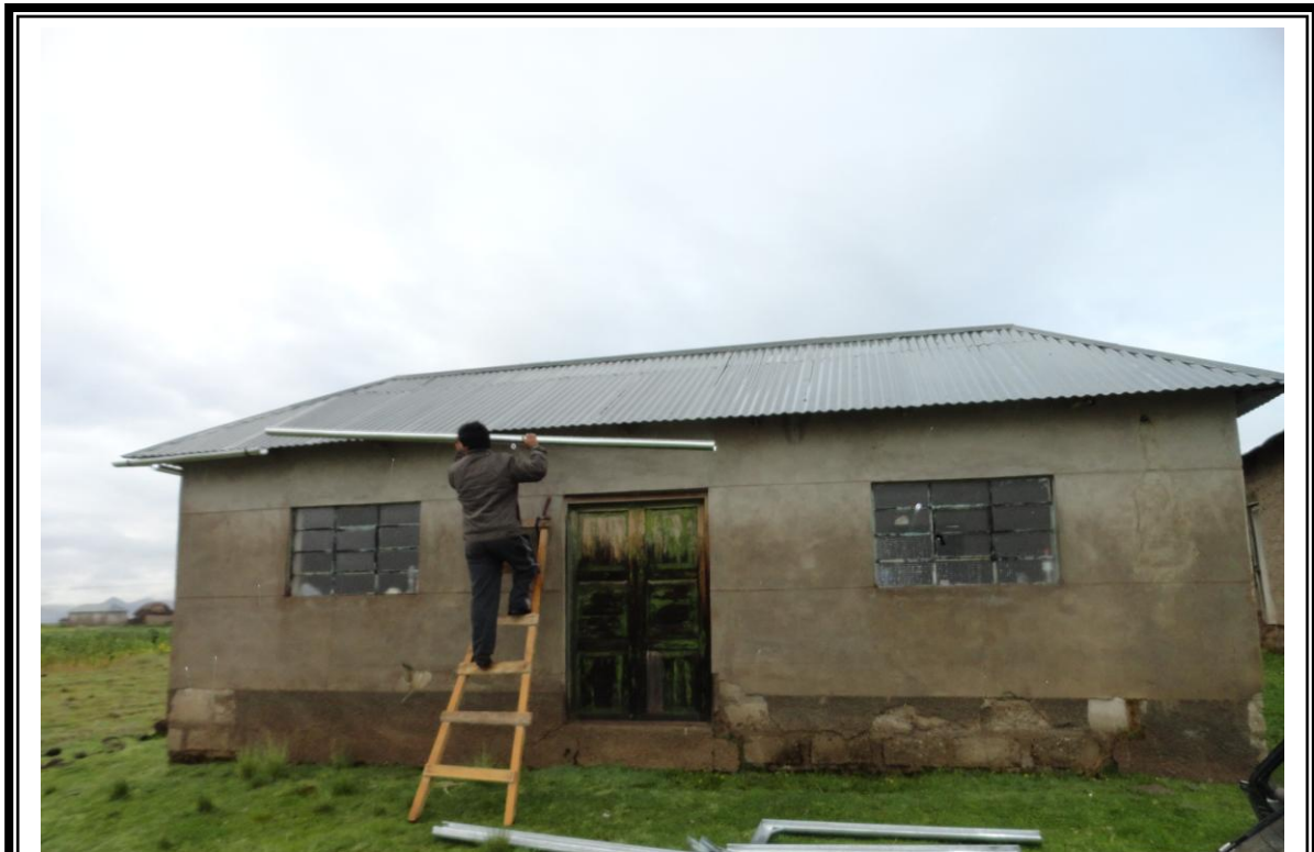
INSTALANDO LAS CANALETAS CON LÁMINA GALVANIZADA
