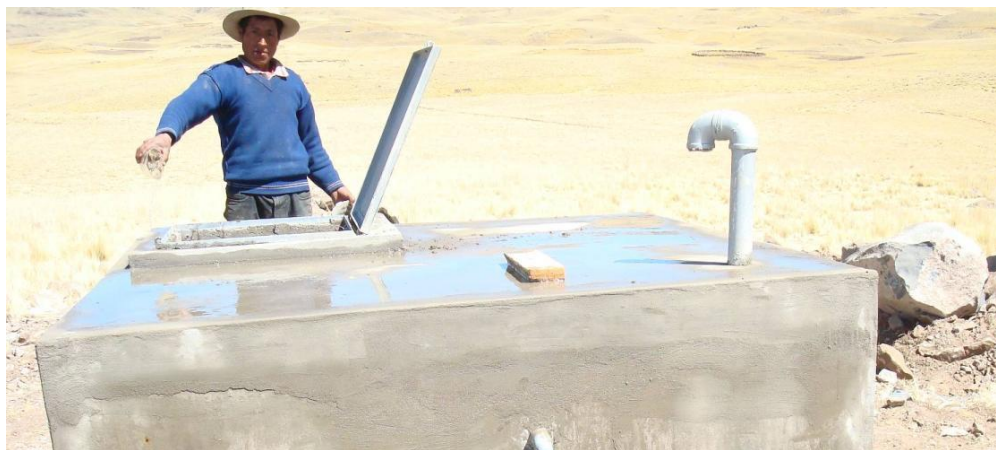
Figura 05: Cisterna de concreto de 40m 3 - 2013. Fuente: Elaboración propio.
