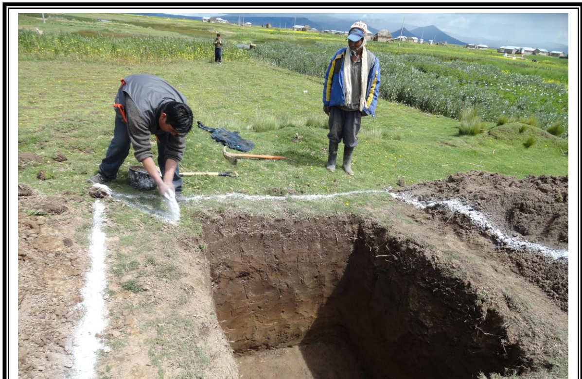
REALIZANDO LA EXCAVACIÓN DEL TANQUE CISTERNA EN LA ZONA DE ESTUDIO
