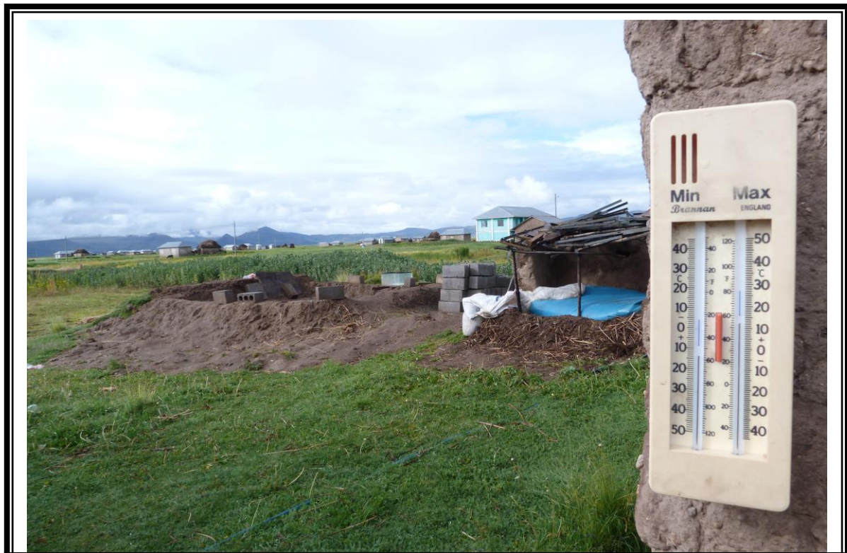
TANQUE CISTERNA EN CONSTRUCCIÓN Y AGUA ALMACENADA EN PLÁSTICOS
