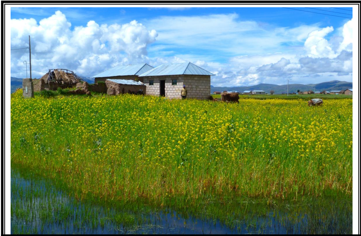
VIVIENDA INUNDADA POR FALTA DE MANEJO DE AGUAS PLUVIALES
